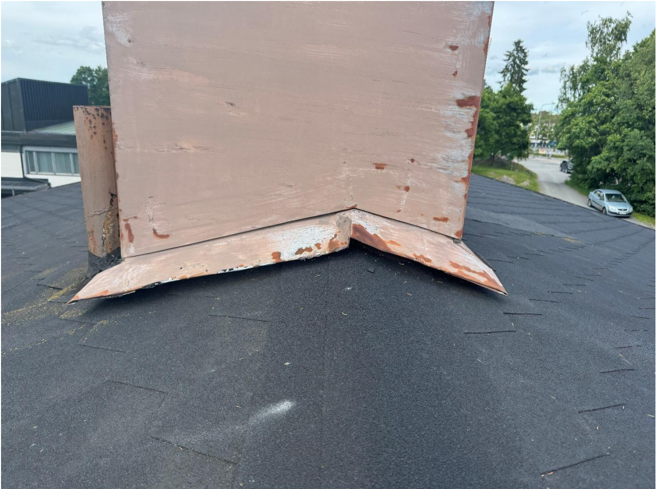
Kuva 2.2. Kalustajantalon peltisen savupiipun reunapellin alla oli lepakolleen sopiva kulkurako.
