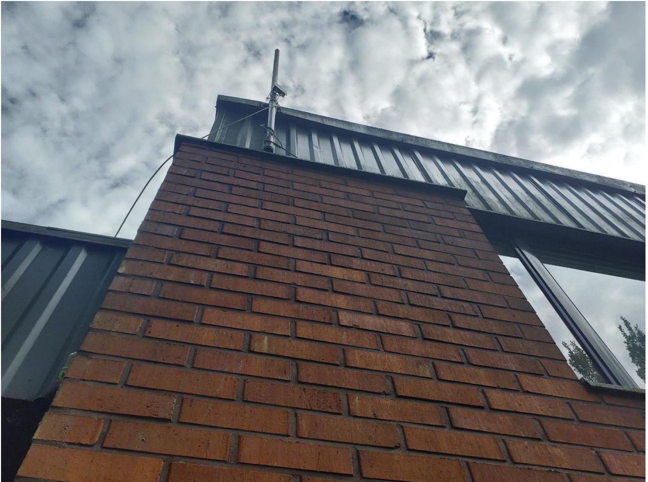
Kuva 2.10. Nuorisotalon seinän ja katon reunapeltien väleihin ei muodostunut koloja, joista olisi päässyt sisään välikattotilaan.
