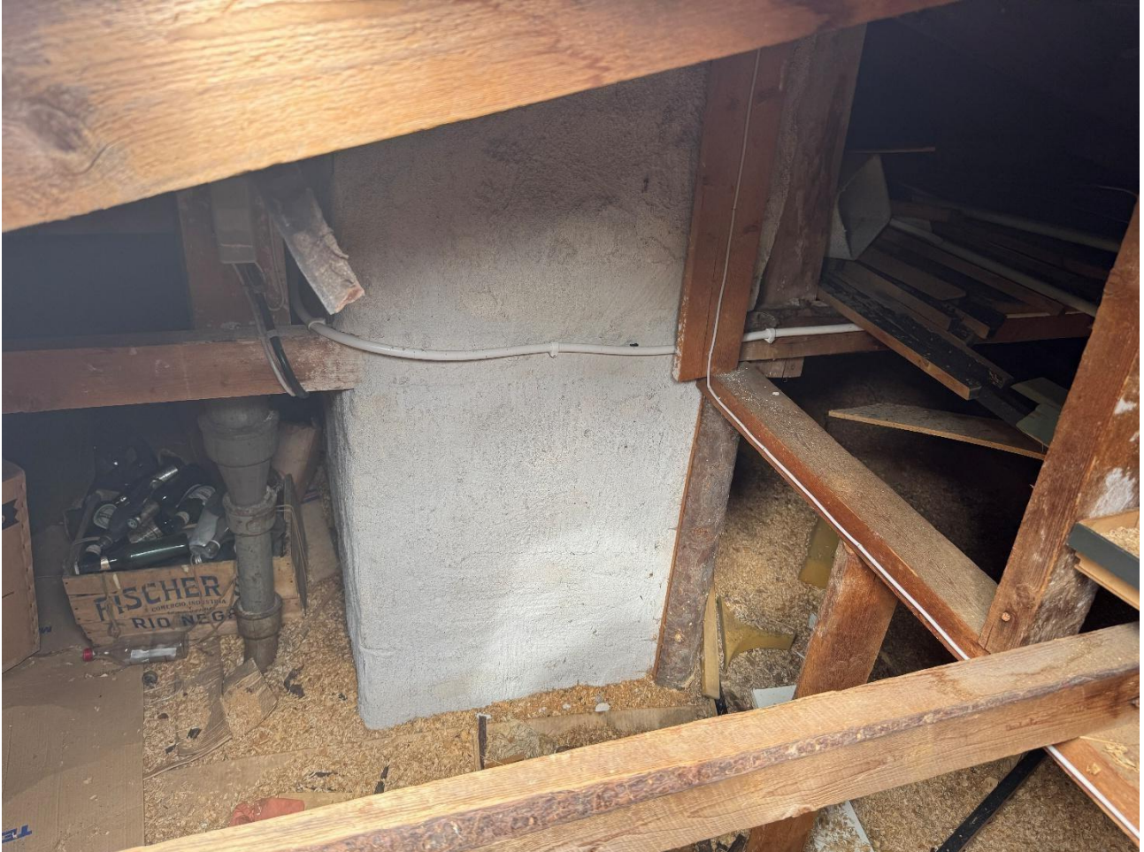
Kuva 2.3. Kalustajantalon välikattoon pääsi katsomaan katolla olleiden luukkujen kautta. Savupiipun muurin ympärillä ei näkynyt lepakonpapanoita.
