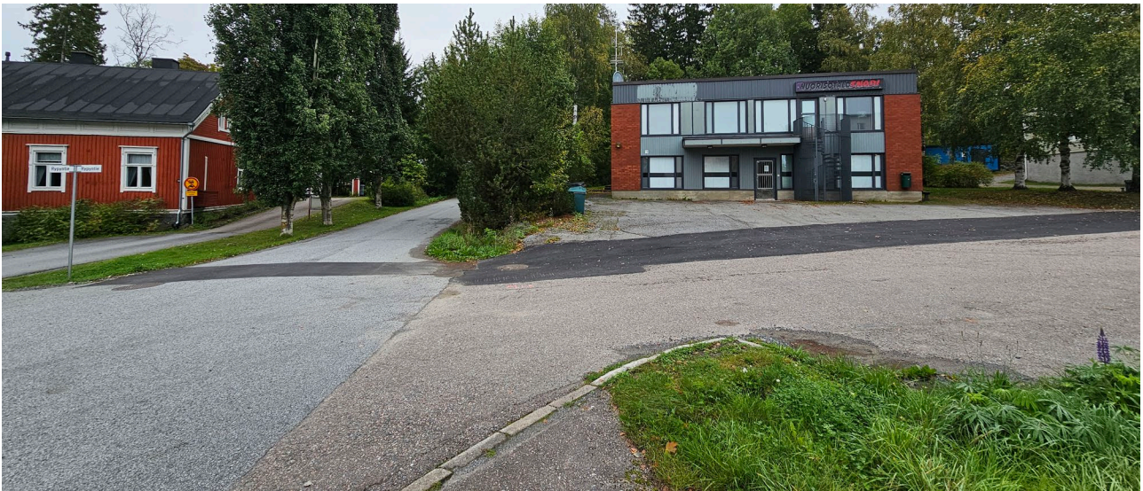
Kuva 8 Rypyntien ja Tarikantien Tampereentien liittyvä risteysalue on mitoitukseltaan hyvin väljä siten, että se haittaa risteuksen ja kaistojen hahmotettavuutta.
