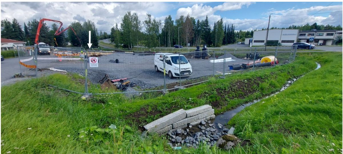
Kuva 4: Rakenteilla oleva tontti ja maavallilla Tampereentien suuntaan käännetty oja. Valkoinen nuoli osoittaa virtausreitintä päättyvää.
