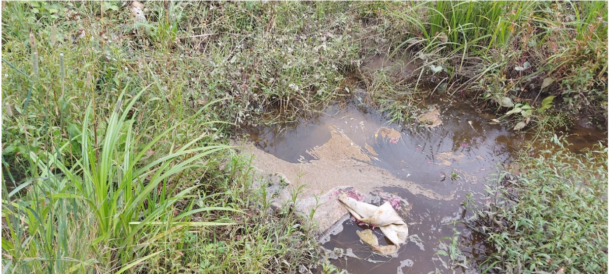
Kuva 3: Tampereentien alitus 800 B eteläisellä/itäisellä pääreitillä. Rumpua ei näy lainkaan ja virtaus rumpuun on hyvin hidasta.
