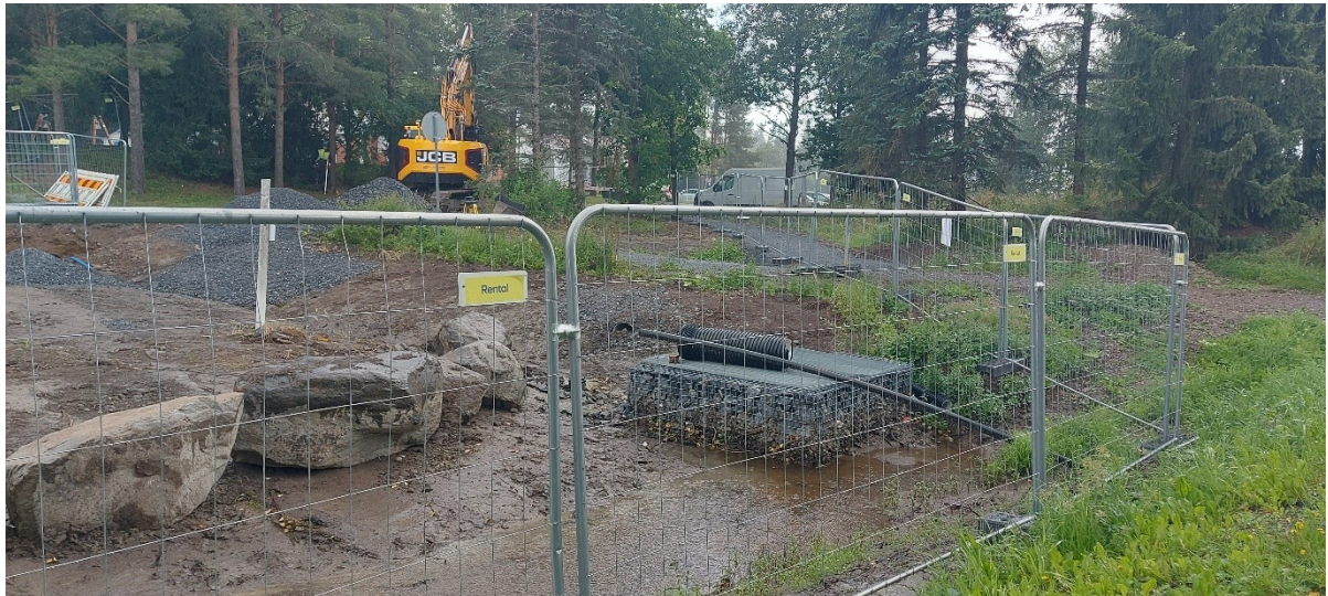
Kuva 5: Virtausreitit päättyvät kivikorein ja teräsverkolla suojattuun kannettomaan betonikaivoon, josta reitti jatkaa tuntemattomalla putkituksella kohti pohjoista (kuvassa taustalla näkyvän pakettiauton suuntaan).
