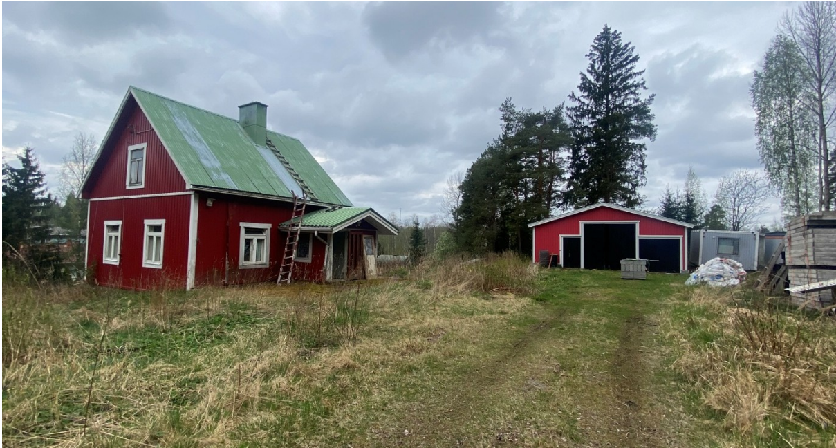
Kuva: Rautalinintie 1:n purettava asuinrakennus (vasen) ja talousrakennus (oikea)
