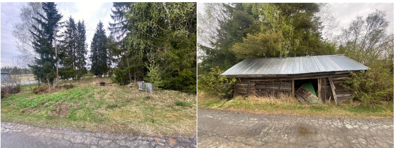
Kuvat: Linjansivu 3:n pohjoisosa on vanhaa huonokuntoista piharakennusta (oikea) lukuun ottamatta lähes kokonaan rakentamaton ja metsistynyt osa kiinteistöä.
