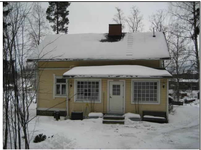
431-6-29 Haljastennokka. Rakennus 1 lounaasta 2009.
