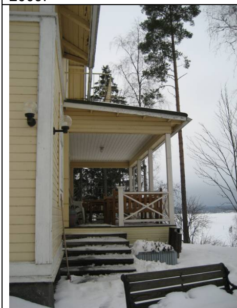
431-6-29 Haljastennokka. Rakennus 1 terassi kaakosta 2009.
