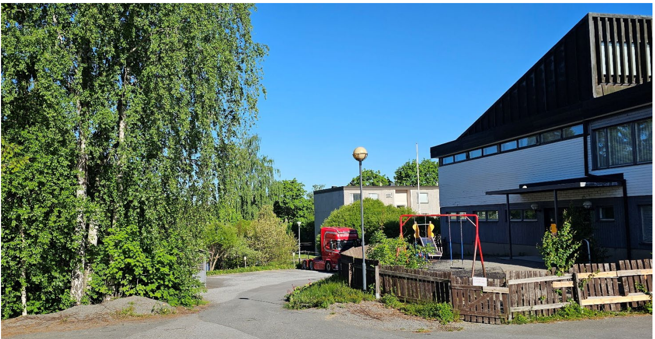
Kuva 4 Lempoisten seurakuntatalo, kerrostalo Asunto oy Lempäälän Kirkkorinne sekä nykyisen Atrantien eteläpää, joka yhdistyy asfaltoituun rinteeseen.
