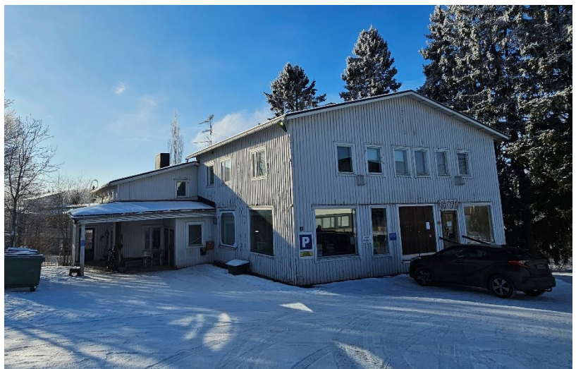
Kuva 6 Kalustajan talo, Atrantie 3, 18.2.2026.
