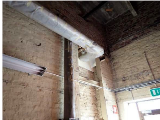
Kuva 2. Näyte HA3, vanha kattilahuone. Seinien keltainen maali ja tasoite eivät sisällä asbestia.
