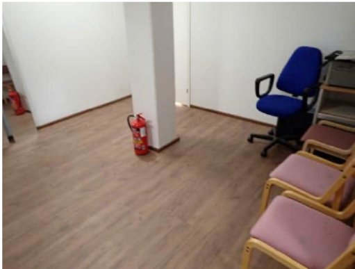
Kuva 5. Näyte HA8k, toimistosiipi, 2 krs. Pilareiden tasoite ei sisällä asbestia.
