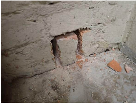
Kuva 39. Tiiliseinistä otettiin näytteet iskuporaamalla saumalaasti tiilen ympäriltä ja irrottamalla tiili. Näytteenotossa varottiin poraamasta tiiltä, jotta tiili ei lämpenisi.
