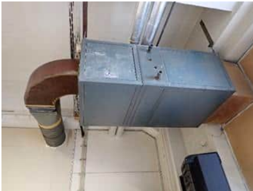
Kuva 41. Vanhat LVIS-järjestelmät saattavat sisältää haitta-ainepitoisia osia sekä haitta-ainepitoisten aineiden jäämiä.
