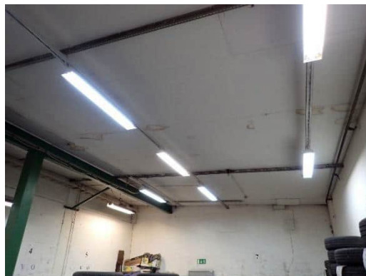
Kuva 18. Yleiskuva rengasvarastona toimivasta laajennuksesta. Sisäpintojen levytykset ovat kipsilevyä.
