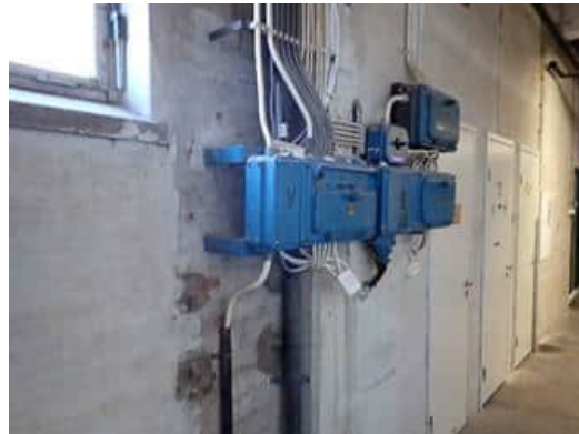
Kuva 42. Vanhat LVIS-järjestelmät saattavat sisältää haitta-ainepitoisia osia sekä haitta-ainepitoisten aineiden jäämiä.
