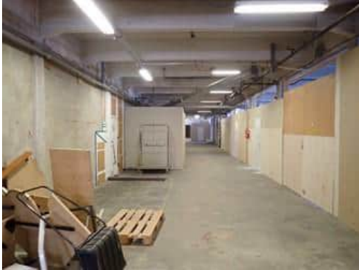
Kuva 33. Toisen kerroksen tehdassali, nykyisin varasto- ja harrastetila. Tiloissa oli aistinvaraisesti arvioituna erittäin vahva öljyn haju.
