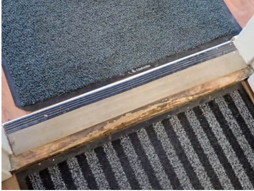
Kuva 7. Näyte HA10, toimistosiiven porrasaula, 2 krs. Kynnysten päällä olevat 300 x 300 lattiaviinyyliilaat ja vaalea kiinnitysliima eivät sisällä asbestia.
