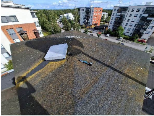
Kuva 12. Yleiskuva hissikuilun vesikatolta. Kuntotutkimuksen mukaan alemmat kermit ovat todennäköisesti alkuperäisiä.
