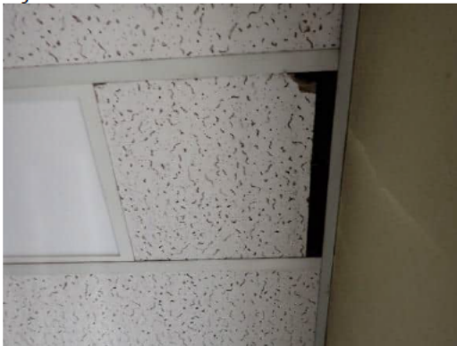
Kuva 3. Näyte HA5, toimistorakennuksen tuulikaappi, 1 krs. Alakaton verhoilulevyt eivät sisällä asbestia.
