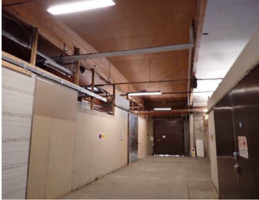
Kuva 19. Yleiskuva alkuperäisen tehdasrakennuksen ja varastolaajennuksen rajakohdasta. Laajennusosan sisätiloissa ei havaittu mahdollisesti asbestipitoisia pintamateriaaleja.
