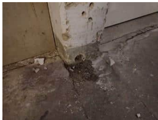
Kuva 38. Rakennuksen pilari. Pilareista otetut osanäytteet kerättiin alareunasta.
