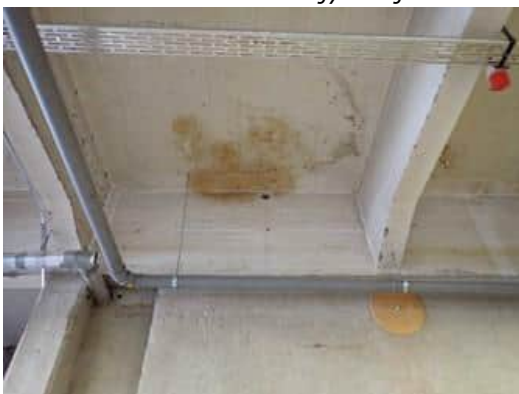
Kuva 37. Rakennuksen palkisto. Palkistosta otetut osanäytteet kerättiin palkiston yläreunasta.
