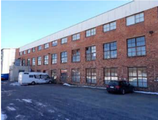
Kuva 4. Tehtassalin länsijulkisivu. Julkisivun yläreunan kuitusementtilevyt sisältävät asbestia.
