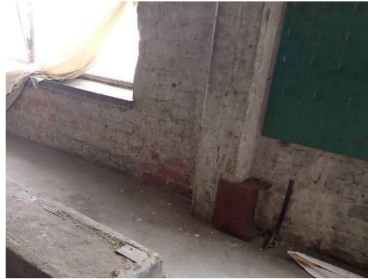
Kuva 40. Yleiskuva tehdassalin tiiliulkoseinästä.
