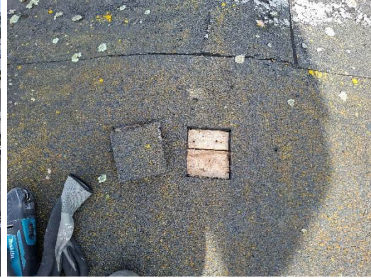
Kuva 13. Näyte HA25. Bitumikermit sisältävät antofylliittiasbestia.
