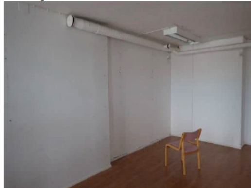
Kuva 6. Näyte HA9k, toimistosiipi, 2 krs. Katto- ja seinätasoitteet eivät sisällä asbestia.
