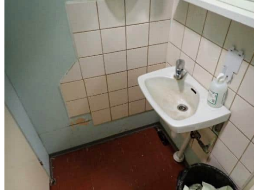
Kuva 8. Näyte HA16, toimistosiiven WC-tila, 3 krs. Alkuperäiset keraamiset laatoitukset ja niiden kiinnitysliimat ja seinätasoitteet eivät sisällä asbestia.
