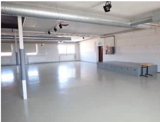
Kuva 35. Kolmannen kerroksen vanha tehdassali, nykyisin kuntosali. Kuntosalin välipohja on pinnoitettu epoksilla. Kolmannen kerroksen tiloissa ei aistinvaraisesti havaittu öljyn hajua.
