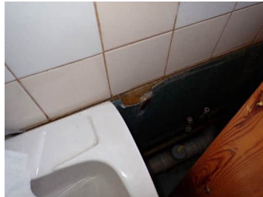
Kuva 10. Näyte HA19, esiintyjien tila 3 krs. Vesipisteiden taustojen ja lattioiden pintamateriaalina oleva muovimatto ja vaalea kiinnitysliima eivät sisällä asbestia. Vastaavaa muovimattoa käytetty myös ympäröivien tilojen pintamateriaalina.
