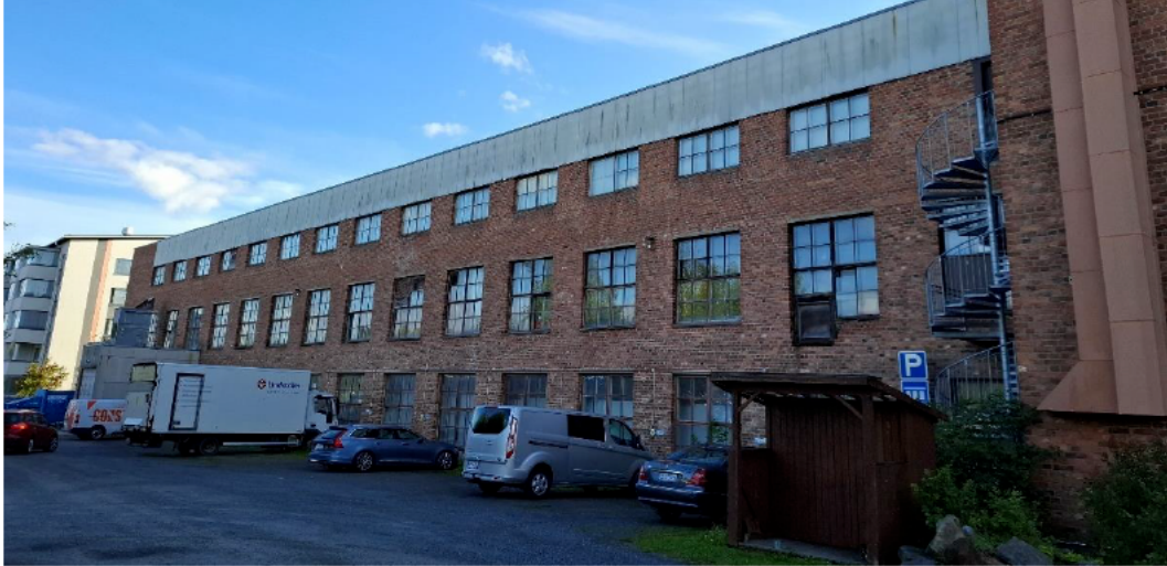
Kuva 3. Yleiskuva tehdasosan länsijulkisivusta.
