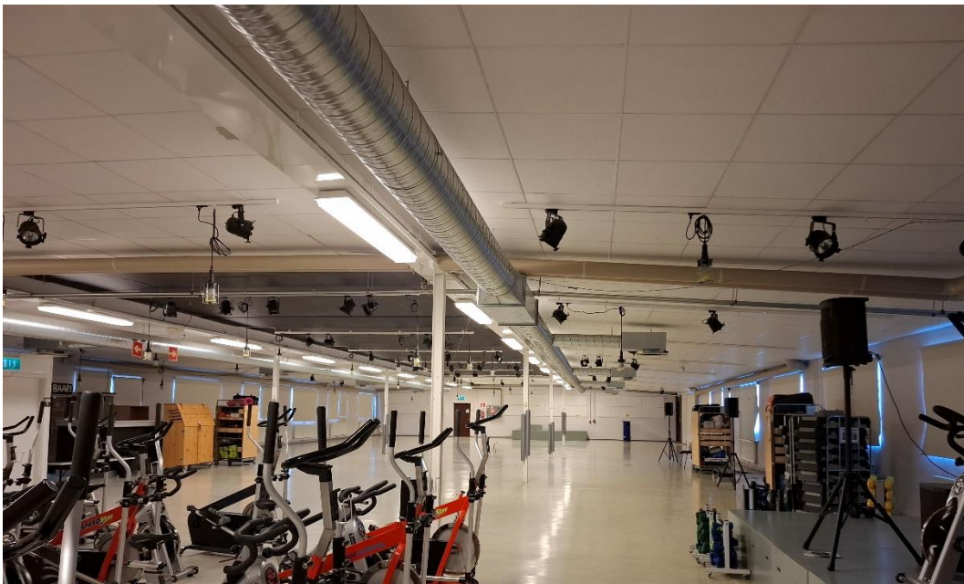
Kuva 64. Yleiskuva kolmannen kerroksen juhlasalin tilasta. Yläpohjan sisäverhouksena on pääosin akustolevy. Akustolevyn alla on kuitusementtilevy.
