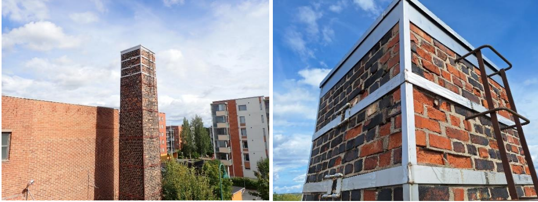
Kuva 38 Yleiskuva tehdasosan itäsivulla sijaitsevasta savupiipusta. Piipun yläosa on peitetty ja tuettu RST-rakenteisella peitelevy ja tukirakenteella.
