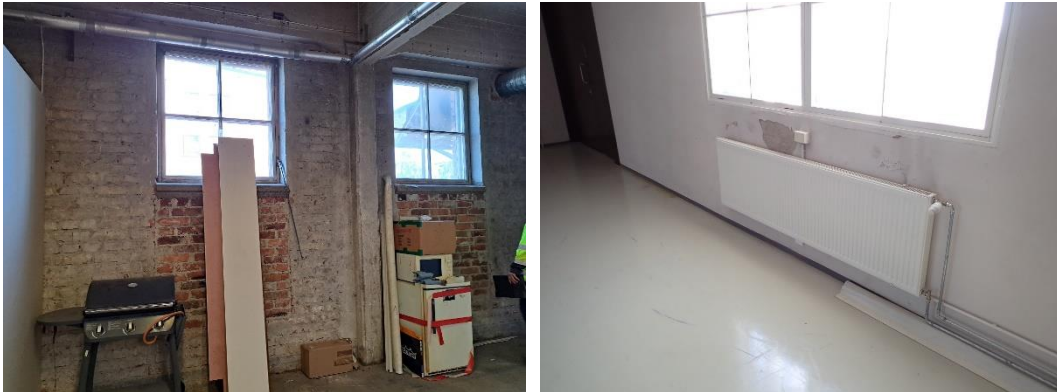
Kuva 34. Osittain sisäpinnat ovat ohuelti tasoitettua sekä osittain tasoitettuja ja maalattuja.
