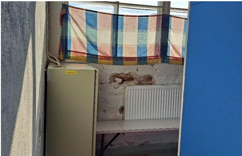
Kuva 35. Ikkunoiden alla on kosteusrasituksen viittaavia jälkiä - kuvassa sisäpinnan tasoite on irronnut todennäköisesti kosteusrasituksen vaikutuksesta.
