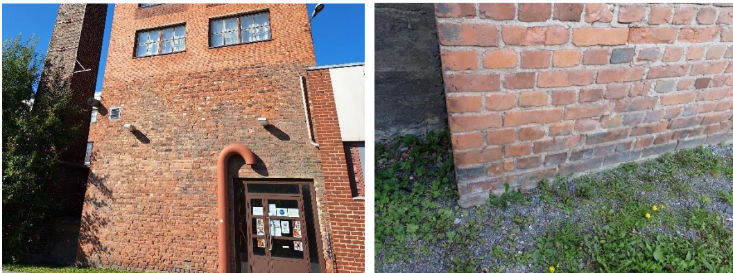
Kuva 12. Itäsiiven sokkeli on maanpinnan tason alapuolella.
