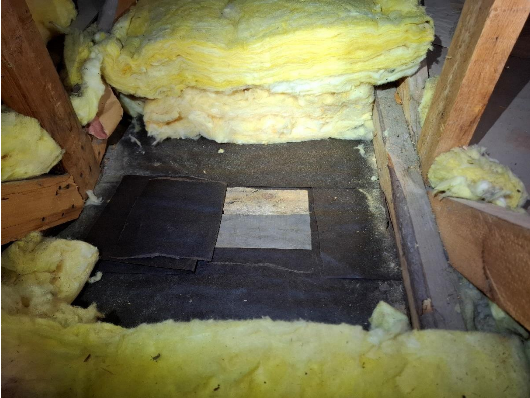
Kuva 61. Rakenneavaus RA2. Rakenteissa ei havaittu viitteitä kosteusvaurioista.
