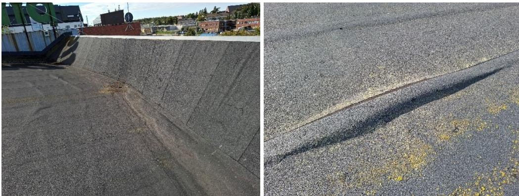
Kuva 47. Esimerkkikuvat kermissä olevista höyrypusseista. Höyrypusseja on paikallisesti enemmän sisätaitejiirien kohdalla. Oikella olevassa kuvassa on esimerkkikuva yhdestä suurimmasta havaitusta höyrypussista. Pintakermissä ei havaittu selkeitä vaurioita höyrypussien kohdilla, mutta kermi vaikuttaa höyrypussien kohdalla tavallista hauraammalta (ratisee päälle astuttaessa).
