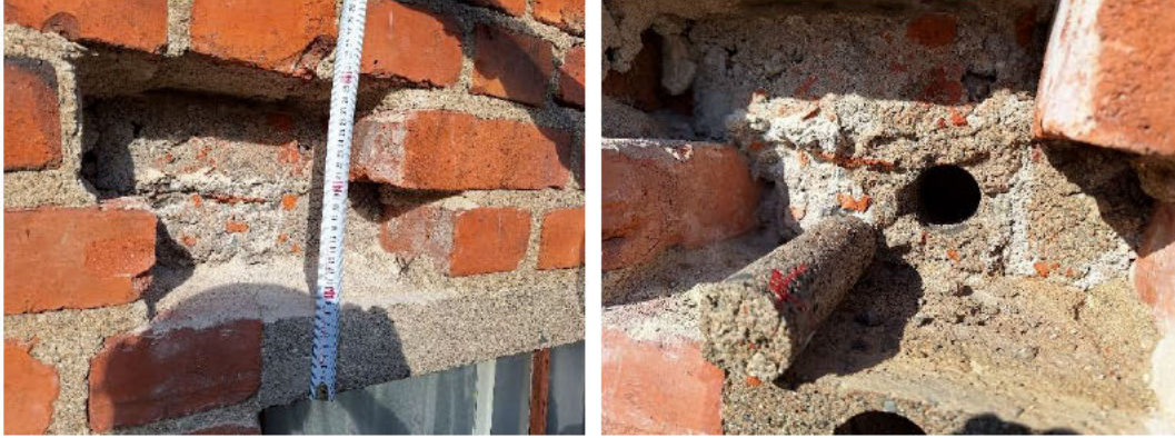
Kuva 14. Alkuperäisen tehdasosan ikkunapalkki. Betonirakenteinen palkki jatkuu julkisivumuurauksen taakse. Alkuperäisen osan ikkunapalkeissa ei havaittu raudoituksia näytteenoton tai peitepaksuusmittarin avulla.
