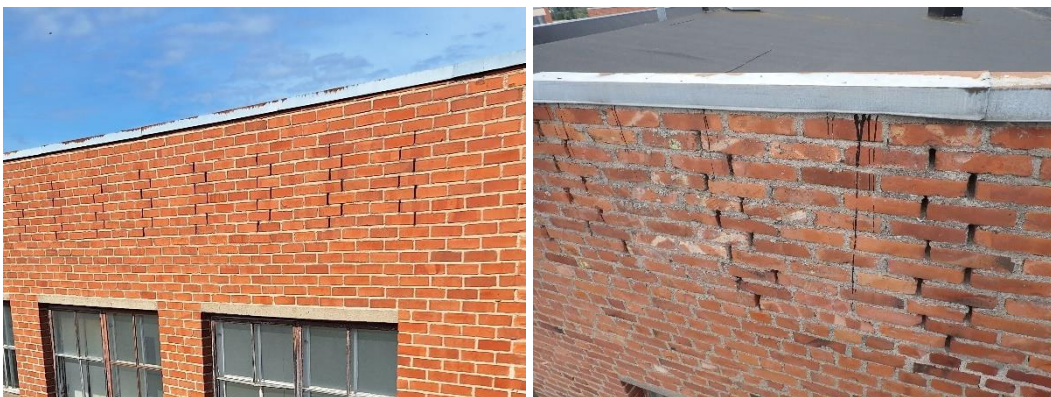
Kuva 56. Julkisivumuurauksessa itäsiivessä ja tehdasosan pohjoispäässä on yläpohjan tuuletusaukkoja, joista on suora yhteys yläpohjien ilmatilaan.
