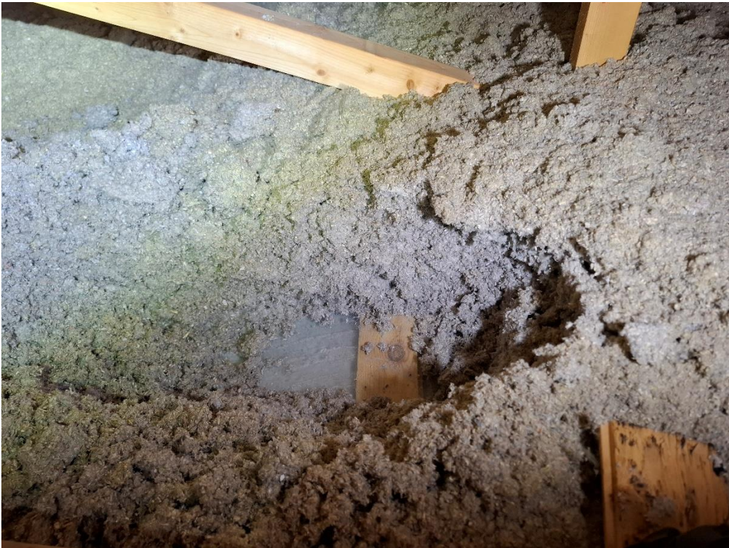
Kuva 62. Rakenneavaus RA3. Rakenteissa ei havaittu viitteitä kosteusvaurioista.
