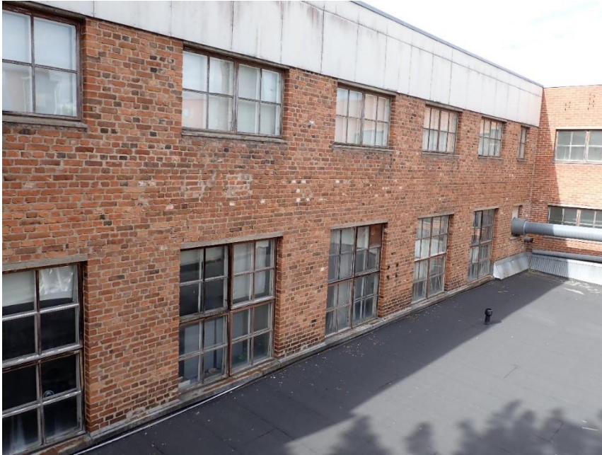
Kuva 13. Yleiskuva. Tehdasosan ylimmän kerroksen ikkunat ja niiden ylityspalkit on rakennettu 1960-luvulla. Seinän yläosan kuitusementtilevyt sisältävät asbestia (AFRY Finland Oy 10.10.2025).
