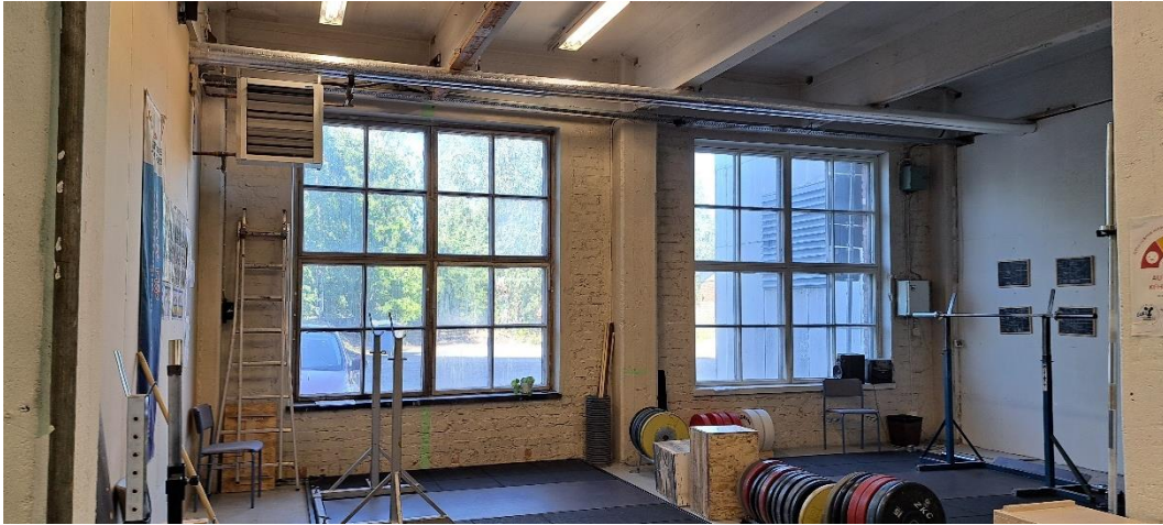
Kuva 33. Kuva 1. kerroksen ulkoseinän sisäpinnasta. Sisäpinta on maalattu.
