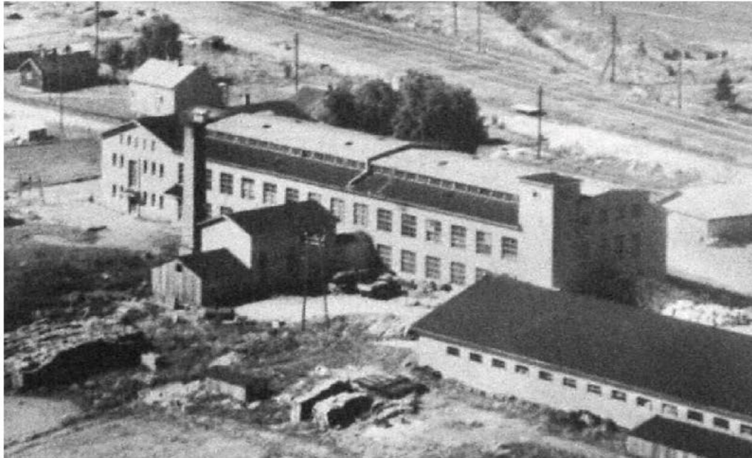
Kuva 6. Viistoilmakuva rakennuksen koillispuolelta vuodelta 1949. Kuvassa näkyy eteläpäädyssä oleva toimisto-osa ennen korotusta ja kattomuodon muutosta. Myös tehdasosaa on sittemmin korotettu ja sen kattomuotoa muutettu. Itäsiipi (piipun vieressä oleva osa) on vuonna 1969 osittain purettu, siirretty sekä korotettu. (Ramboll Finland Oy, 2024; alkuperäinen kuvallähde: Piippo Oy)
