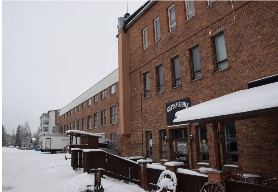
Kuva: Rakennuksen länsijulkisivua.
