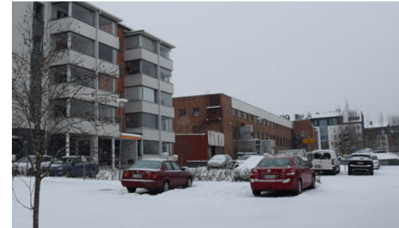
Kuva: Piippokeskus jää katukuvassa ympäröivien kerrostalojen varjoon.
