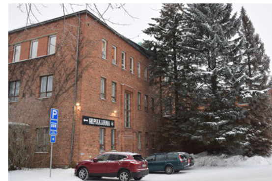
Kuva: Nykyään vanhan sisäänkäynnin merkitys julkisivussa on epämääräinen.
