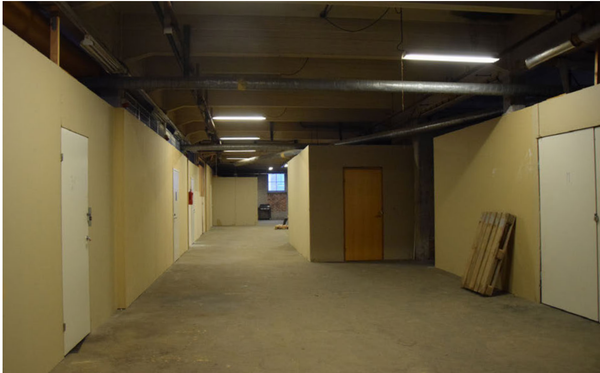
Kuva: Toisessa kerroksessa tehdassali on kevyillä rakenteilla kopitettua raakatilaa.
