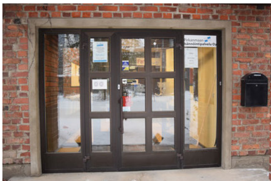
Kuva: Toimisto-osan pääovi
