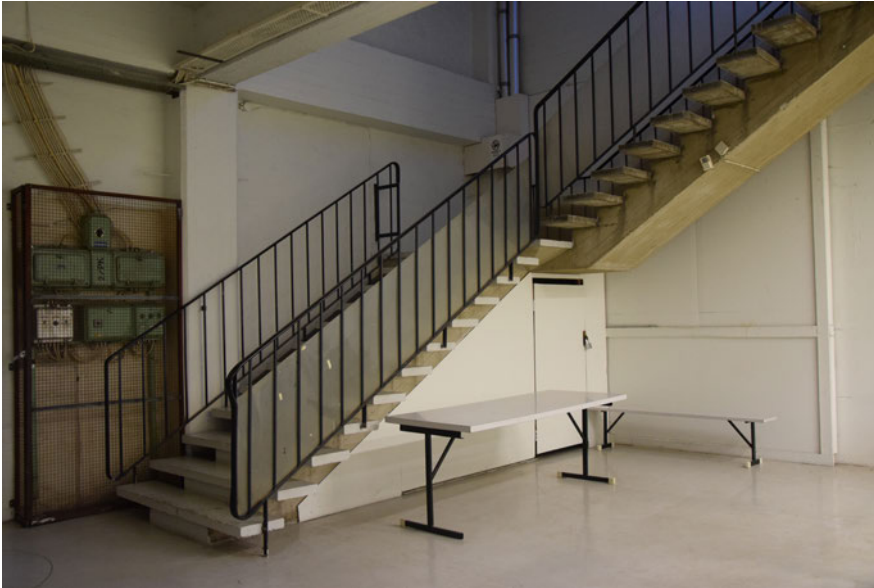
Kuva: Itäsiiven keskipalkillinen betoniporras rakennettiin vuonna 1969. Mustat pinnakaiteet ovat teräsrakenteiset, paarteet taivutettua lattaterästä. Alimpien syöksyjen kaiteissa on lisäksi pleksilasit.
