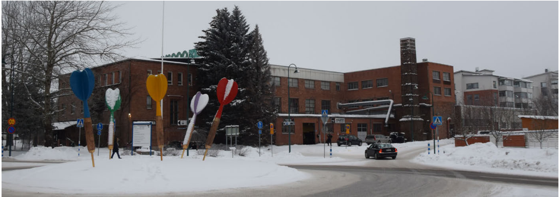
Kuva: Piippokeskus kaakkoiskulmasta kuvattuna. Tehtaan alkuperäinen savupiippu on rakennuksen katujulkisivun huomiota herättävin elementti. Etualalla Pekka Jylhän taide-teos, joka viittaa tehtaan valmistamiin tikkataulutuotteisiin.
