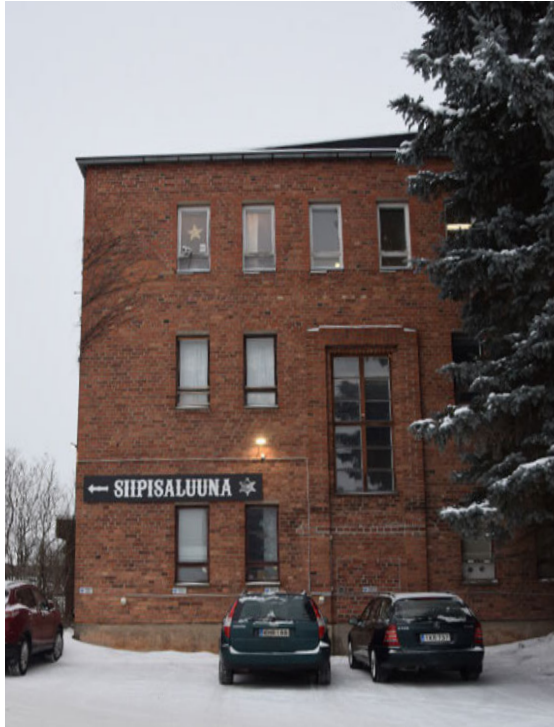
Kuva: Toimisto-osan pääsisäänkäynti on alun perin ollut itäisivulla; porrashuoneen ovea ja ikkunaa on korostettu kehystävällä julkisivuaiheella. Oven paikka on murattu umpeen ja katos poistettu.
