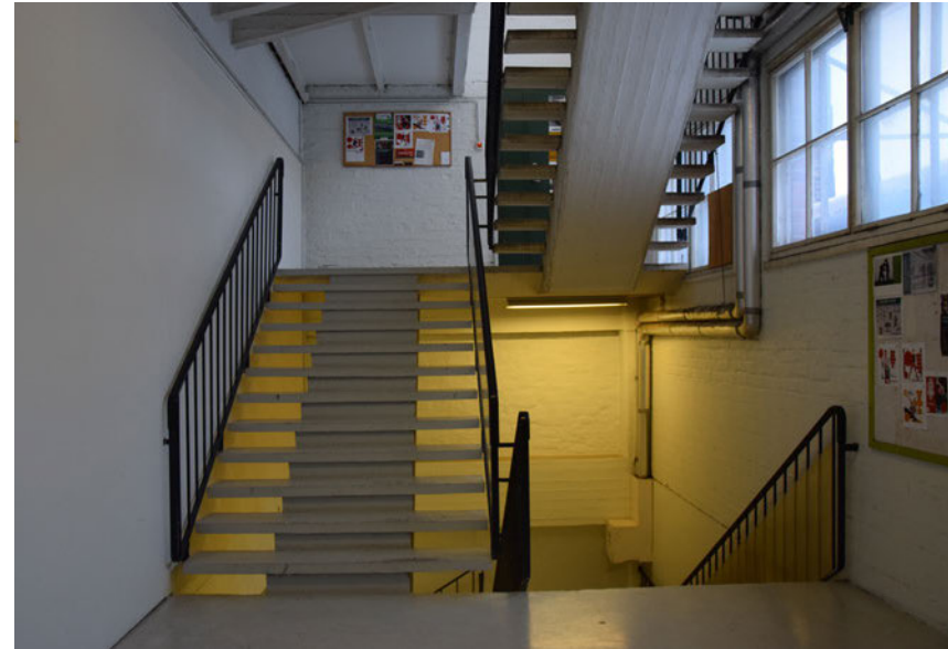
Kuva: Porrashuoneen ilme on valoisa. Ulkoseinän maalattu tiilipinta on tilassa näkyvissä.
