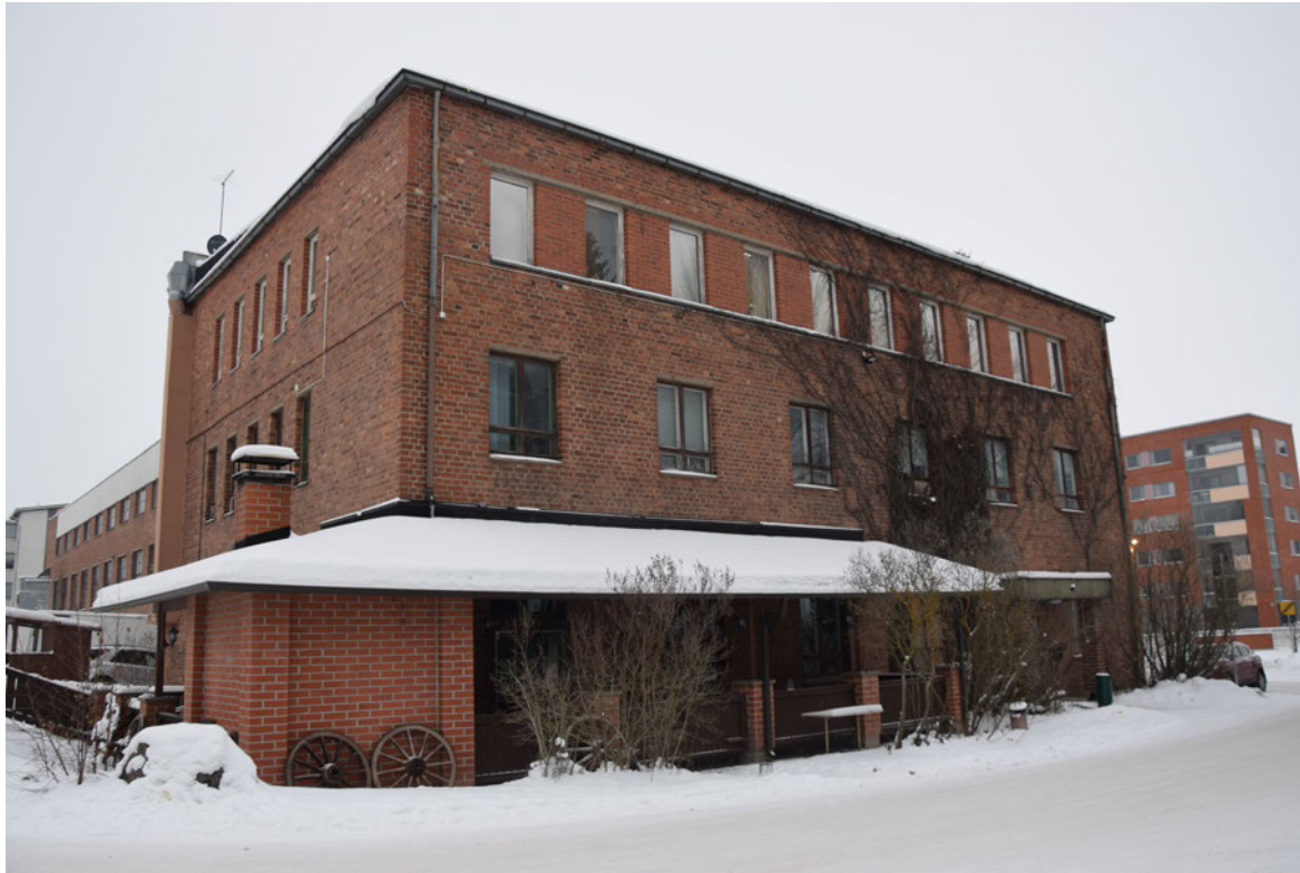
Kuva: Eteläpäädyn julkisivusta on luettavissa ajallisia kerrostumia. Ylimmän kerroksen ikkunarivistö (1960-luvulta) on toteutettu poikkeavaan tyyliin. Ravintolan terassia rajaava tiilirakenne katoksineen lienee rakennuksen viimeisimpiä lisäyksiä.
