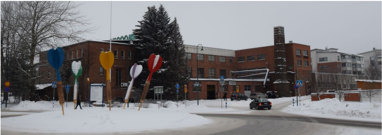
Kuva 4 Piippokeskus kaakkoiskulmasta kuvattuna. Tehtaan alkuperäinen savupiippu on rakennuksen katujulkisivun huomiota herättävin elementti. Etualalla Pekka Jylhän taideteos, joka viittaa tehtaan valmistamiin tikkataulut tuotteisiin.
