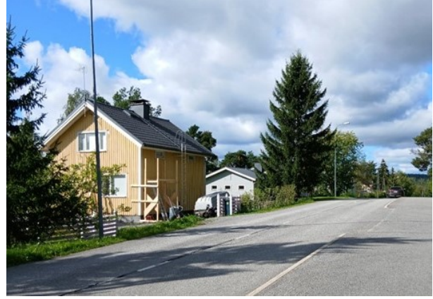
Kuva 11 Katunäkymä Purotien risteyskohdasta Palomäentietä alamaakeen länteen.
