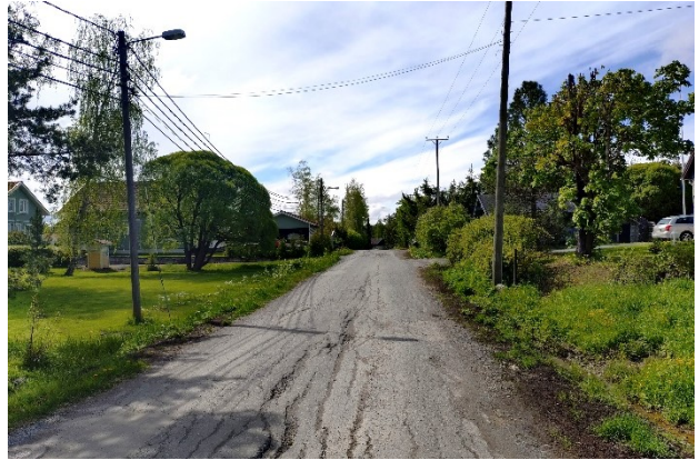
Kuva 17 Katunäkymä Kulmatietä etelään.
