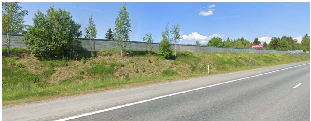
Kuva 2. Nykyinen meluvalli ja -seinä valtatiellä 3 © Google Maps 2023.
