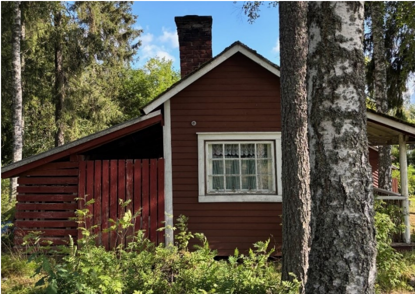
Kuva: Aarnenpolku 5 saunarakennus.
