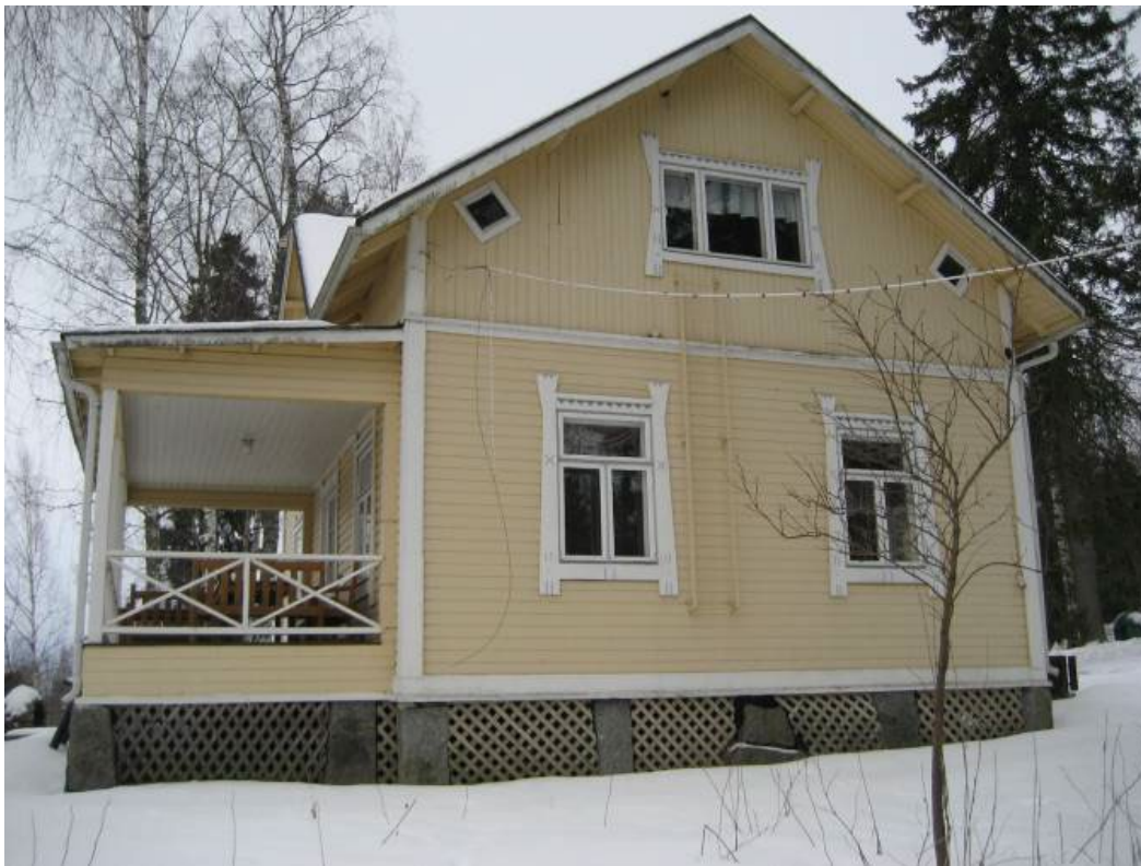
Kuva 3 Lempäälän keskustan kohteiden kulttuuriympäristöinventointi: Rakennus 1 luoteesta 2009.
