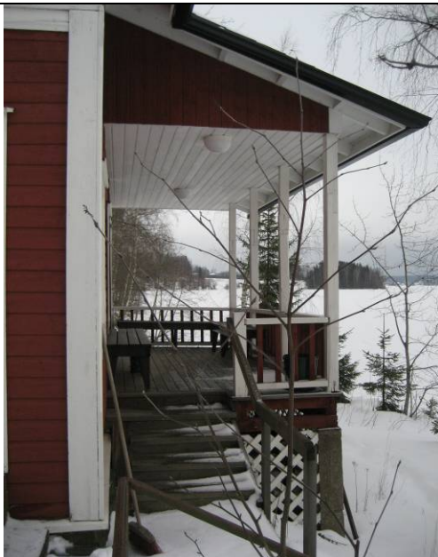
431-6-29 Haljastennokka. Rakennus 2 terassi kaakosta 2009.
