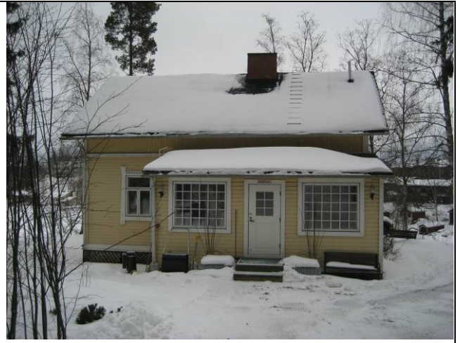
431-6-29 Haljastennokka. Rakennus 1 lounaasta 2009.
