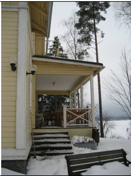
431-6-29 Haljastennokka. Rakennus 1 terassi kaakosta 2009.
