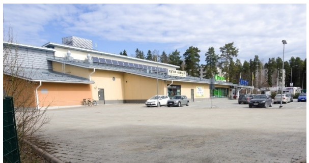
Kuva 6 S-market, Tampereentie 453, kuva 5.3.2024.
