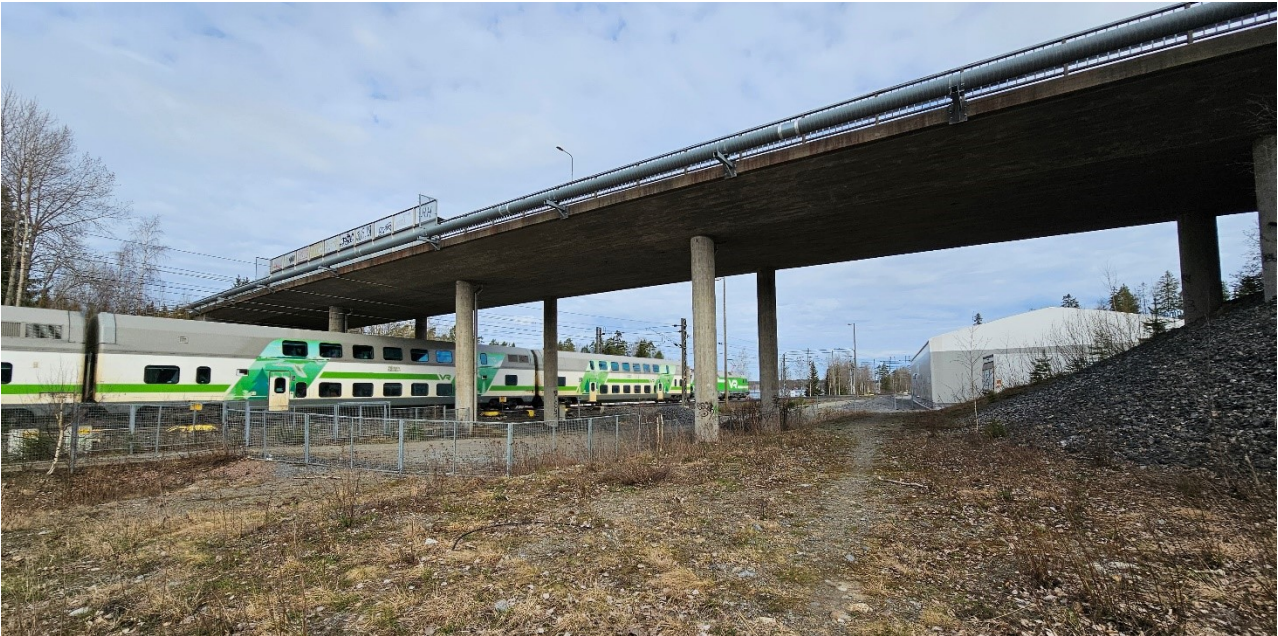
Kuva 1 Sääksjärven ylikulkusilta Sääksjärventien kohdalla, kuva 5.3.2024.
