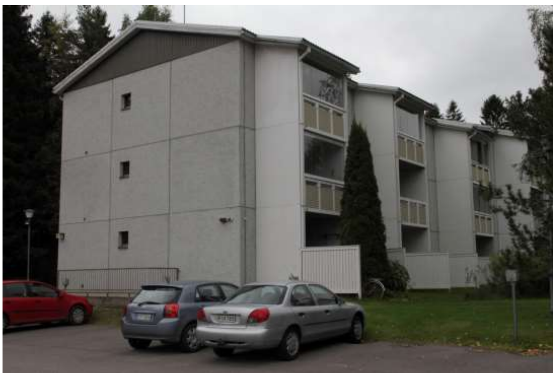
Kuva 96. Ansunkorventie 2 ja 4 ovat pesubetonipintaisia elementtikerrostaloja 1980- ja 1990-lukujen taitteesta. Rakennusten runkoa on hieman porrastettu. Parvekkeiden kaiteet ovat puuta. 3355
