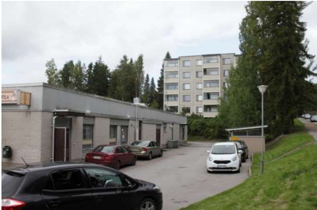
Kuva 82. Pitkänahteentien varren 5-kerroksisia pistetaloja ja tiilivuorattu ostoskeskus 1970-80-lukujen taitteesta. 2942
