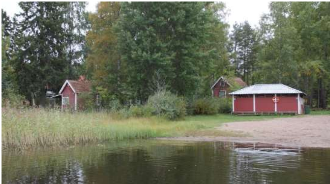
Kuva 117. Höytämöntien varressa Paununlahden rannalla on säilynyt useita 1920-40-lukujen melko vaatimattomia mökkejä. Kuvassa uimarannan viereinen edelleen loma-asuntona oleva mökki ja sen talousrakennus rannassa. Vuoden 1952 peruskartassa ranta on jo täyteen rakennettu ja usean mökin pihapiiriin on merkitty kartassakin puutarha. 1950-luvulla oli tyypillistä, että perhe vietti koko kesän mökillä ja pihapiirissä oli laajat kotitarveviljelykset. 3241
