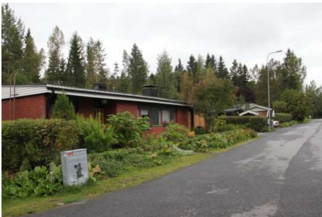
Kuva 79. Kivekkääntien ulkokehällä tien eteläpäässä on enimmäkseen 1970-luvun matalia tiilipintaisia asuintaloja. Talot sijoittuvat lähelle tielinjaa. 3129
