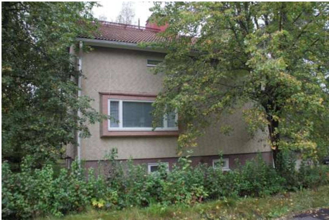
Kuva 73. Lehmustie 7 on tyypillinen 1950-luvun asuintalo, jonka yksityiskohdat, kuten iso erkkeri-ikkuna, kertovat sodan jälkeisen rakennustarvikepulan helpottumisesta. Talon ulkorapauksessa on koristeellinen kuviointi. 3106
