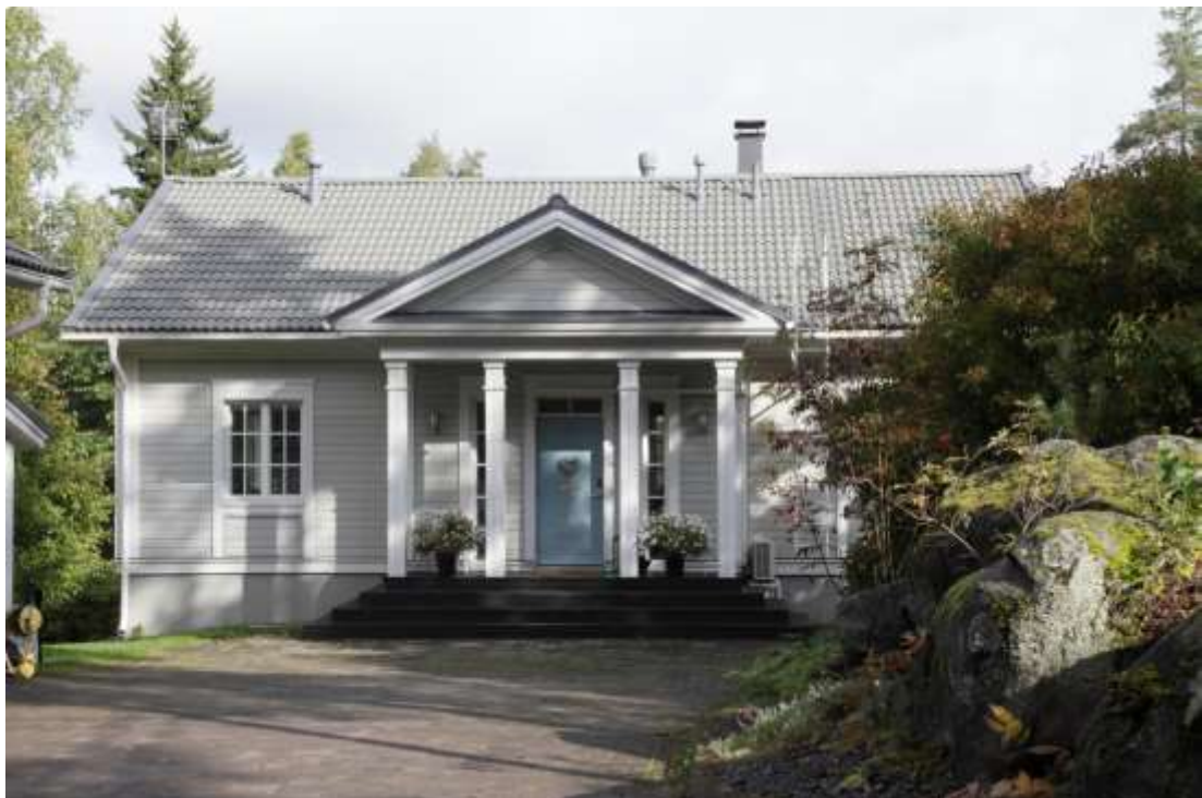
Kuva 27. Sipiläntie 20 on huvilarakentamista jäljittelevä asuinrakennus 2000-luvulta. 2844
