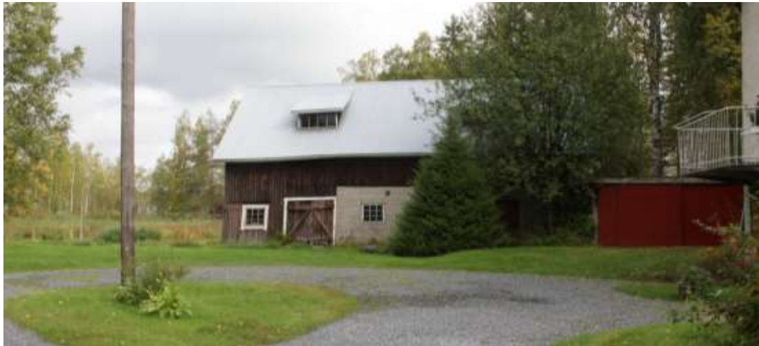
Kuva 45. Koivulan navetta on hieman irrallaan muusta pihapiiristä. Taustalla näkyy edelleen avointa rantaniittyä. Navetan vieressä on 1960-luvun asuinrakennus. 2909
