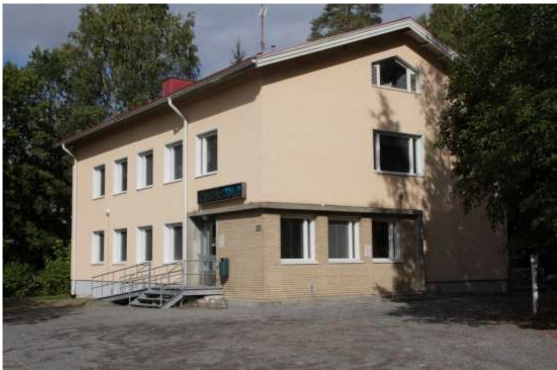
Kuva 85. 1950-luvun pienkerrostalo, jonka alakerrassa on ollut liiketilaa (Tampereentie 426). Liiketiloiissa on nykyisin Sääksjärven nuorisotila. 2977
