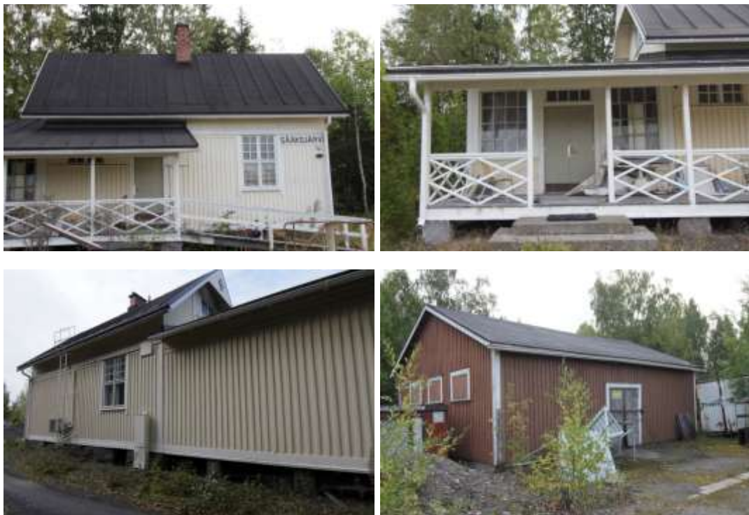
Kuva 16. Yläkuvissa asemarakennuksen radan puoleista julkisivua. Ylhäällä oikealla klassistinen laajennus 1920-luvulta. Alhaalla vasemmalla asemarakennuksen itäjulkisivu ja oikealla makasiinirakennuksen radanpuoleinen julkisivu. 2762,2750, 2753, 2756
