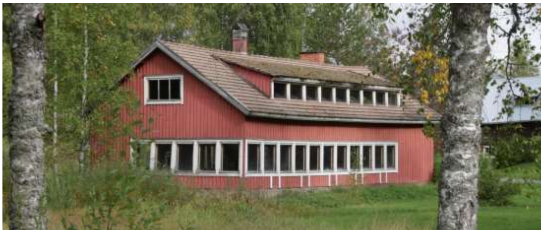
Kuva 46. 1960-luvun asuinrakennuksen pihapiirissä on talousrakennus. se on saanut rakennusluvan vuonna 1962 kanalaksi. Rakennuksessa on pitkä rivi ikkunoita ja myös ullakkokerroksessa on pitkä rivi ikkunoita kattolyhdyn alla.
