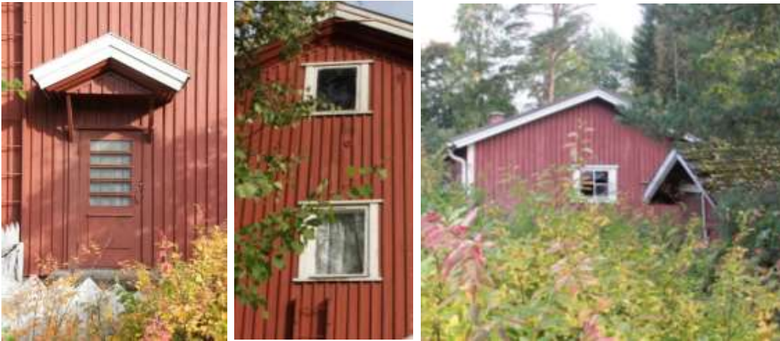
Kuva 19. Säcksjärvitalon eteläjulkisivulla on säilynyt sivusisäänkäynti alkuperäisessä asussaan. Myös ikkunat vaikuttavat alkuperäisiltä.2771, 2772, 2773
