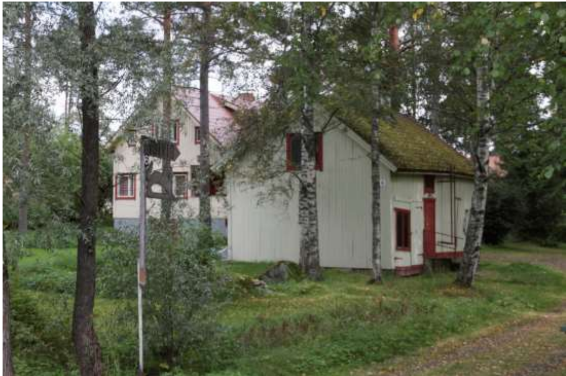
Kuva 57. Rotikonperä 6 on asuntotila jälleenrakennuskaudelta. 2096
