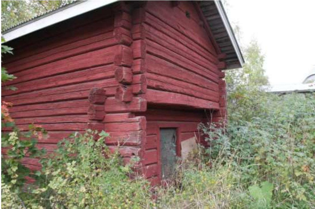
Kuva 139. Hirsirakenteinen aitta on siirretty paikalle. 3466
