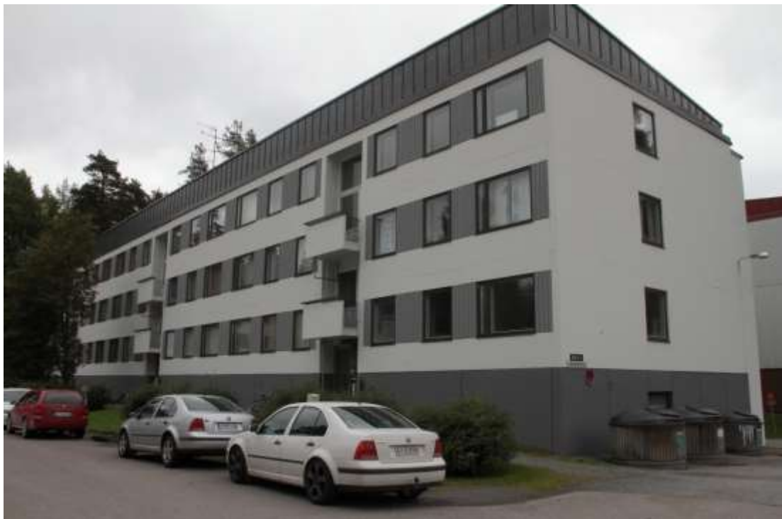
Kuva 92. Tampereentie 414 G-I on lamellitalo vuodelta 1969. Sen julkisivut on maalattu vastikää. Samalla sävy maailmaan on uudistettu raikkaammaksi. 3349
