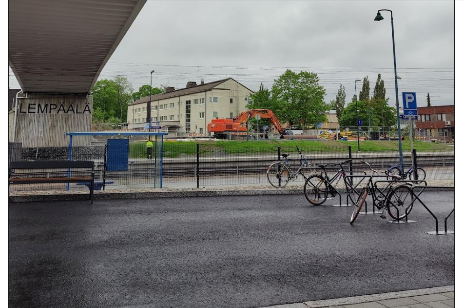
Runkolukittavia pyörätelineitä Kuljussa ja asemalaiturin vierellä. Sillan kansi ei suojaa pyöriä sateelta.
