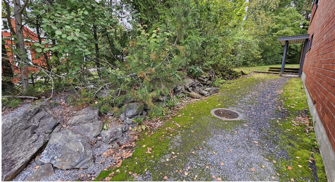
Kuva 11 Rakennuksen ja Tarikantien välissä on kivimuuri.
