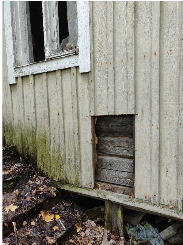
Kuva 17 Vasemmalla: puut kasvavat rakennuksen vierustaa. Keskellä: julkisivun avauksesta paljastuu hirsirunko. Oikealla: kostea maan pinta on rakennuksen itäpuolella julkisivun rajassa.
