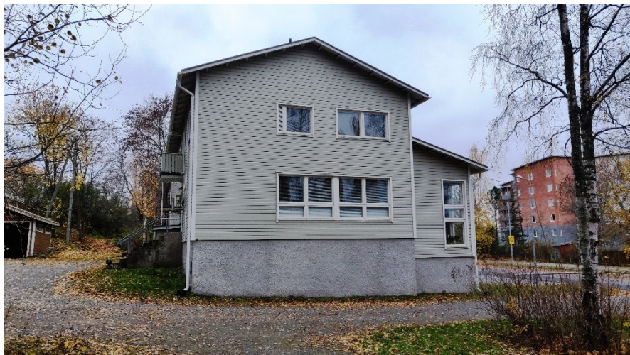
Kuva 22 Rakennuksen julkisivu pohjoiseen Snadin suuntaan.
