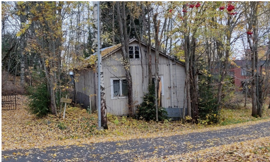
Kuva 16 Rakennus Tarikantien varrella. Puut kasvavat kiinni rakennuksessa.
