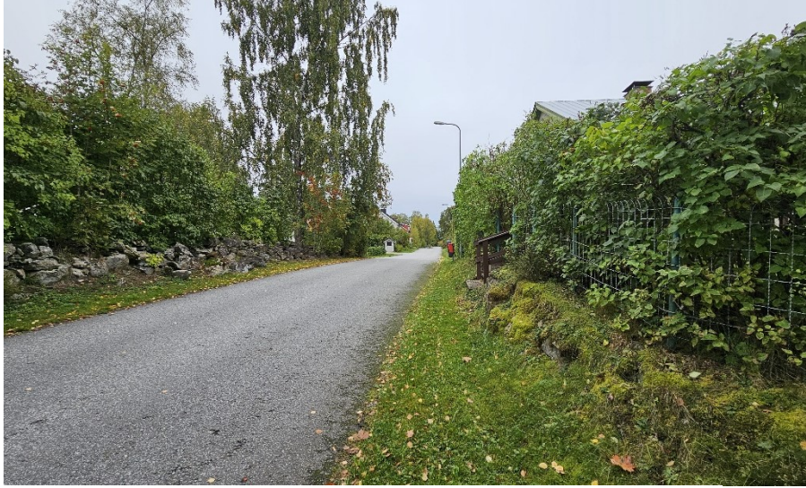
Kuva 7 Tarikantietä reunustavia kivimuureja.
