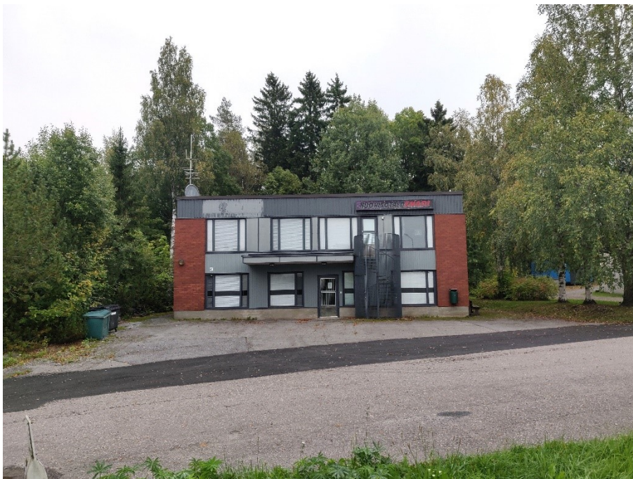
Kuva 10 Julkisivu Tampereentien suuntaan.
