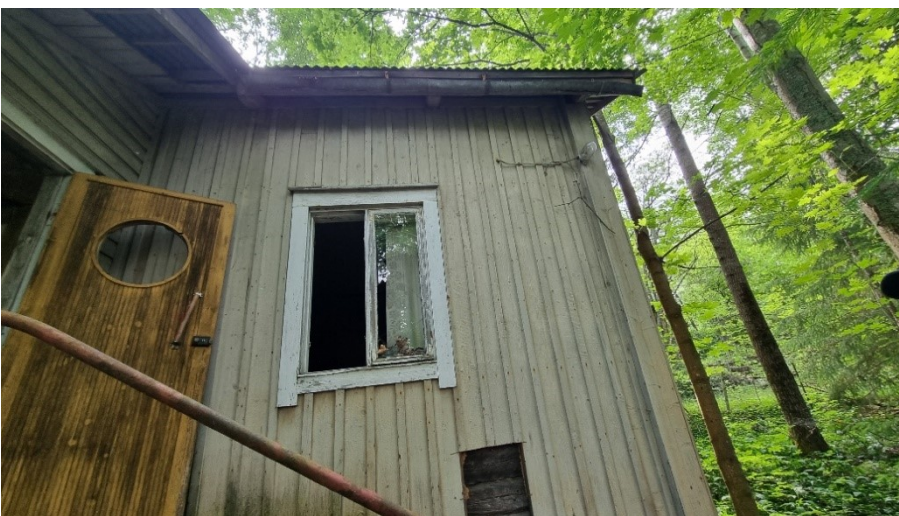
Kuva 5. Talon länsipuolta, jossa ikkunat ja ovet avoimena.
