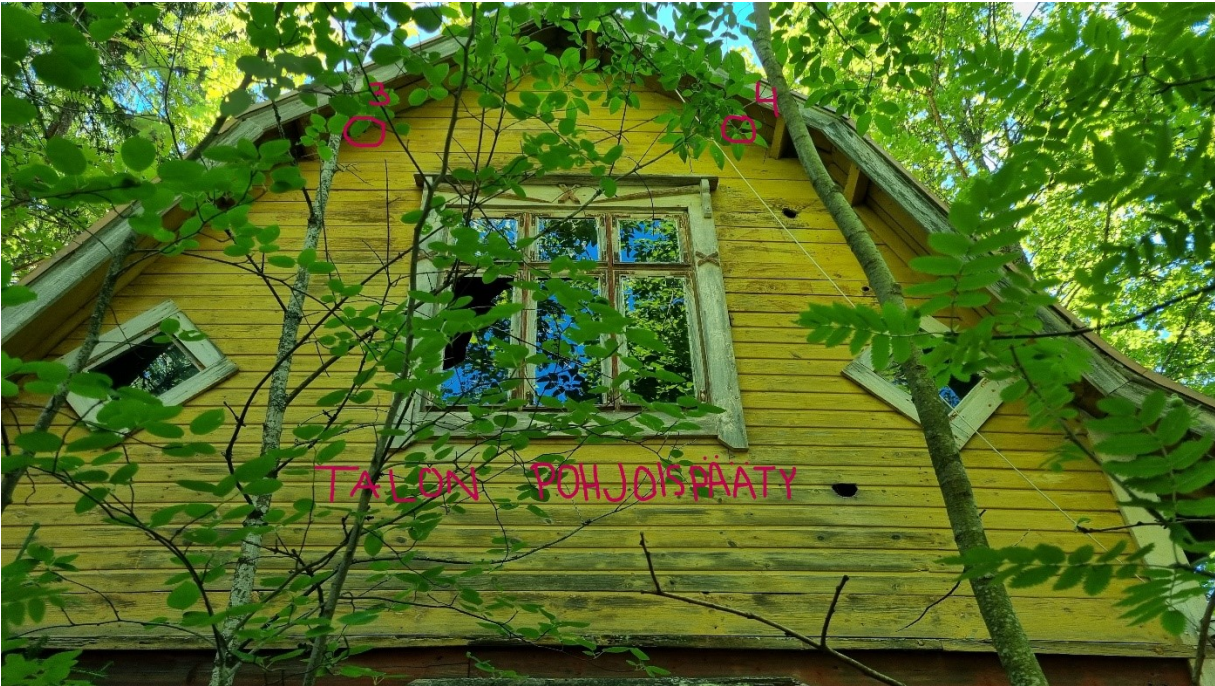
Kuva 11. Tarikantie 3 rakennuksen pohjoispäädyn yleiskuva, merkittynä 2 koloa, joissa tarttumajälkiä.
