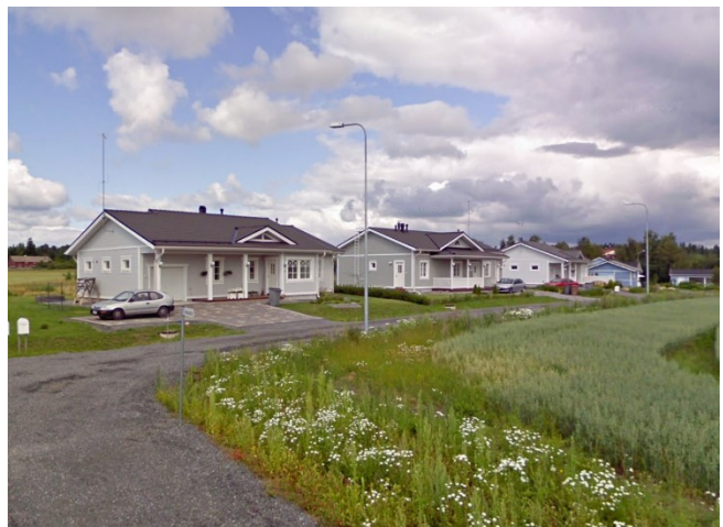
Kuva: Suunnittelualueen pohjoispuolelle sijoittuvaa uudemmaa rakennuskantaa.
