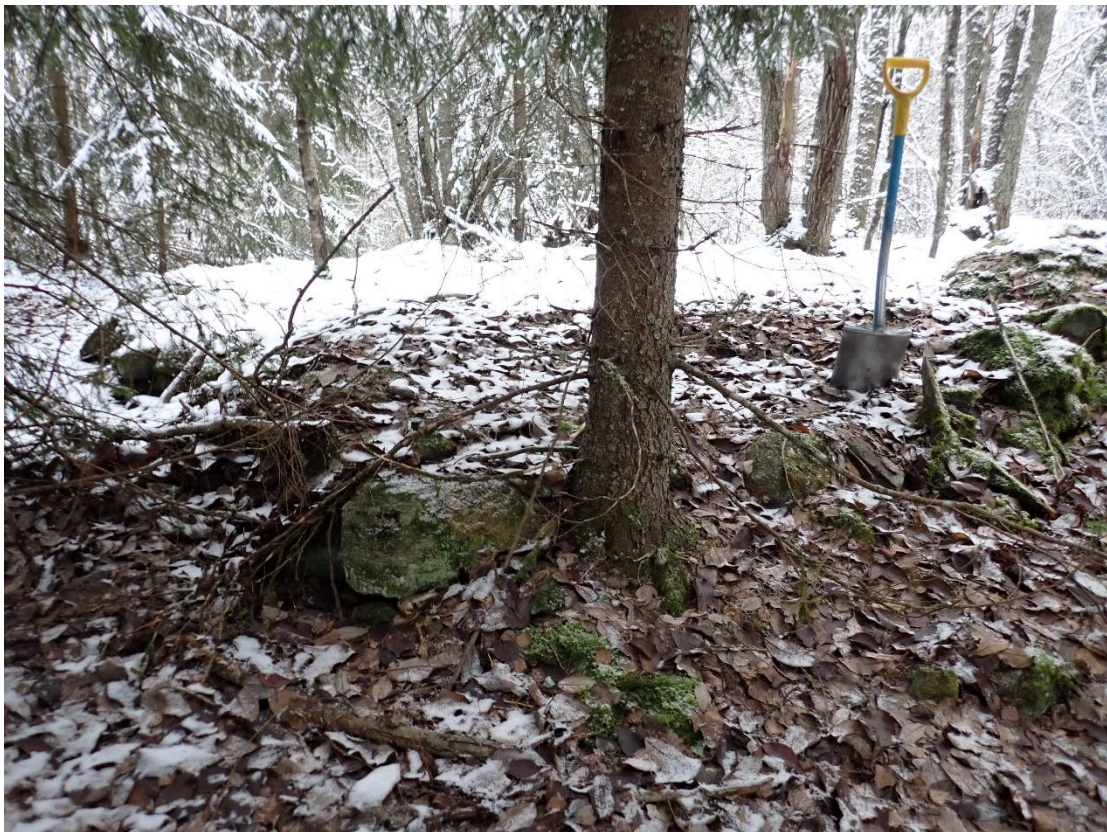
Havaintokohta 1. Rakennuksen perustuksen luoteiskulma. Lounaaseen.
