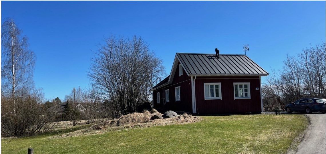
Veljespolku 7:n päärakennus pohjoisesta, Veljespolun suunnasta.
