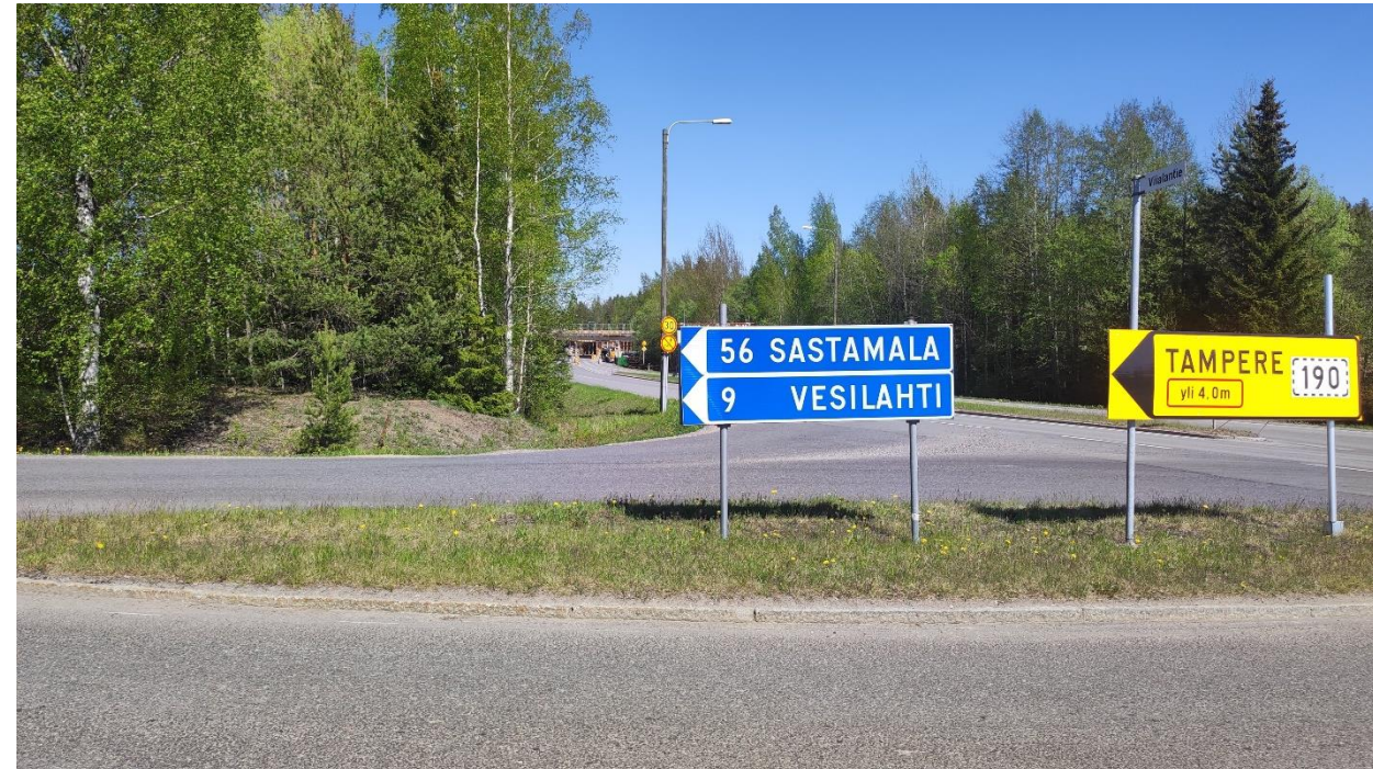
Kuva: Valokuva Turuntien ja Viialantien liittymästä pohjoiseen. Kuva on otettu noin 12 metriä Turuntien reunasta. Kasvillisuuden lisäksi tieviitat hankaloittavat näkemää pohjoiseen.
