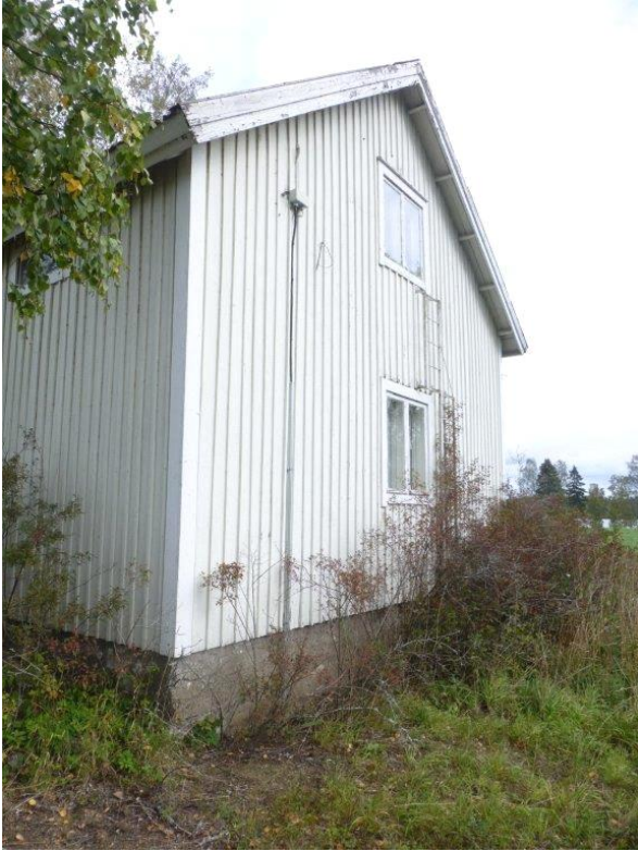
Kuva, Myllyvainion vanha sivuasuinrakennus
