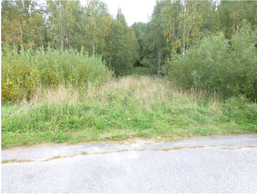
Kuva, Luhdankanta-niemeen kulkevaa valmista tiepohjaa.
