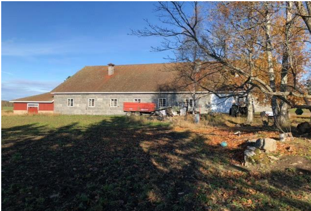
Kuva, Suuri navetta on säilynyt hyvin, nykyinen käyttötarkoitus on ollut varastorakennus, rakennusta ollaan muuttamassa kokoontumis- ja juhlatilaksi. Navetta on arvioitu valmistuneen 1800-luvun alkupuolella, länsipuolella oleva matalampi laajennusosa on rakennettu myöhemmin.
