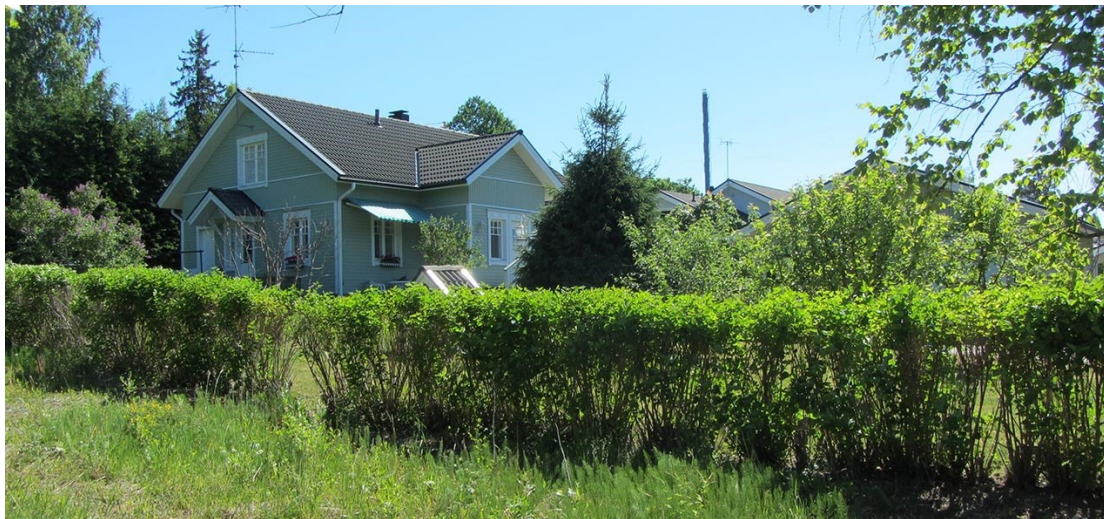
Kuva 4. Haljastentien rakennuksia pohjoisesta.
