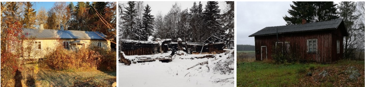
Kuva 25, 26 ja 27. Vasemmassa kuvassa Kauniston päärakennus ennen paloa, keskimmäisessä kuvassa palon jälkeen. Oikeassa kuvassa Lietsalan asuinrakennus.
