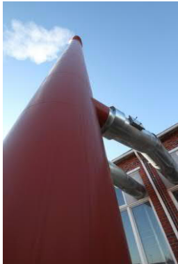
Kuva 33. Tehtaan vanha punatiilinen savupiippu jouduttiin uusimaan vuonna 2009. Uusi piippu on teräsrakenteinen.
