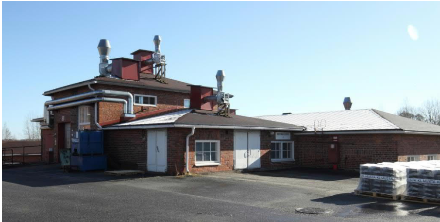
Kuva 35. 1950-luvulla valmistunut kemiallinen tehdas on nykyisin tehtaan uudempien osien ympäröimä ja näkyy vain tehtaan sisäpihalle. Kuvassa näkyy kemiallisen tehtaän länsi- ja eteläjulkisivut.
