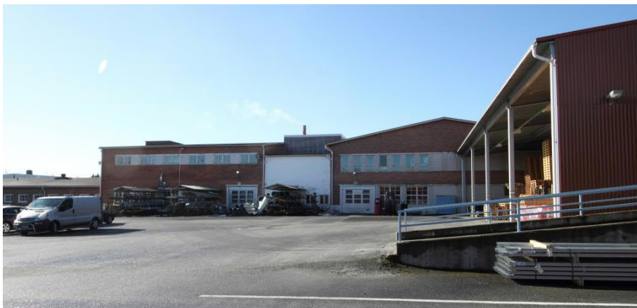
Kuva 37. Kemiallisen tehtaän jatkeena olevan 1950-luvulla valmistuneen korjaamon pohjoisjulkisivulla näkyy nauhaikkunat. Korjaamo näkyy nykyisin vain tehtaän sisäpihalle uuden varastohallin takia.
