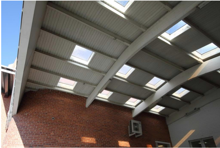
Kuva 29. 1960-luvun lastauslaiturin katosta kannattaa muottiin valetut, kaarevat teräsbetonipalkit.
