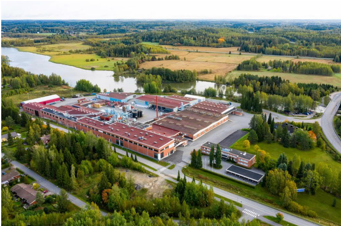
Kuva 40. Ilmakuva lounaasta kohti Katepalin tehdasaluetta. Tehdaskompleksi näkyy kuvan keskellä. sen oikealla puolella näkyy konttori ja konttorin edustalla oleva autokatos. Konttorin ja kuvan oikeassa reunassa näkyvän Katepalintien välissä tehdään tontti on puistomaista nurmikkoa. Kuvan etualalla näkyy Hollon asuinalueella olevia rivitaloja sekä Nurmisaarentien ja Rata tien välisiä tyhjiä tontteja. Tehtaan taustalla näkyy Herralanvuolle ja Herralankoski. Niiden takana on avointa peltomaisemaa. Kuvaaja: Jimi Soinila. Kuvälähde: Katepal Oy.
