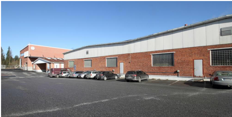
Kuva 30. Tehdaskompleksin eteläjulkisivua hallitsee 1960–1970-luvuilla rakennetut varastohallit. Hallien ikkunat ovat lasitiiltä. Seinien yläpinta on mineriittilevyä. Taustalla näkyy 1960-luvun lastauslaituri ja 2000-luvun laajennus.
