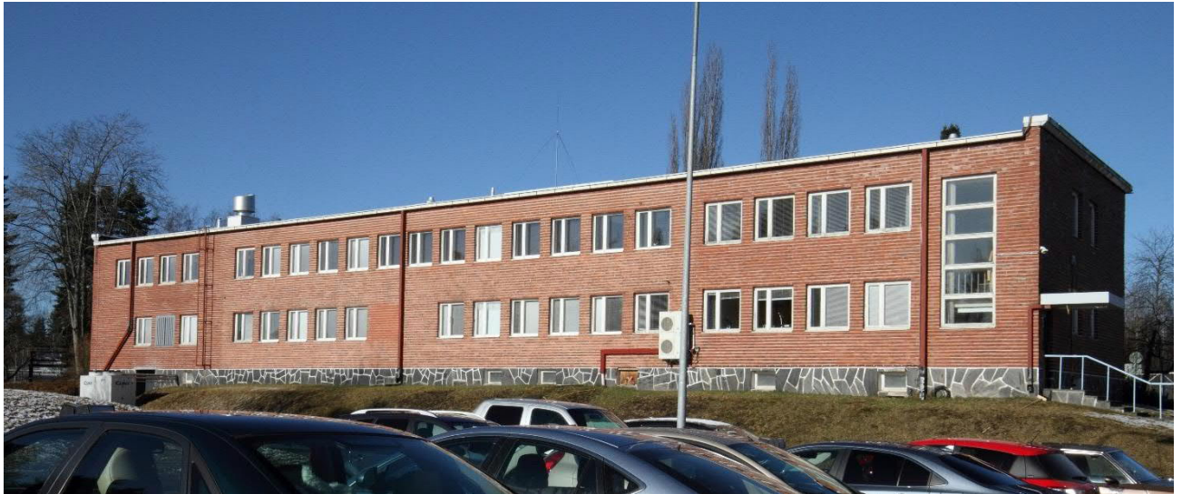
Kuva 45 Konttori, julkisivu itään.
