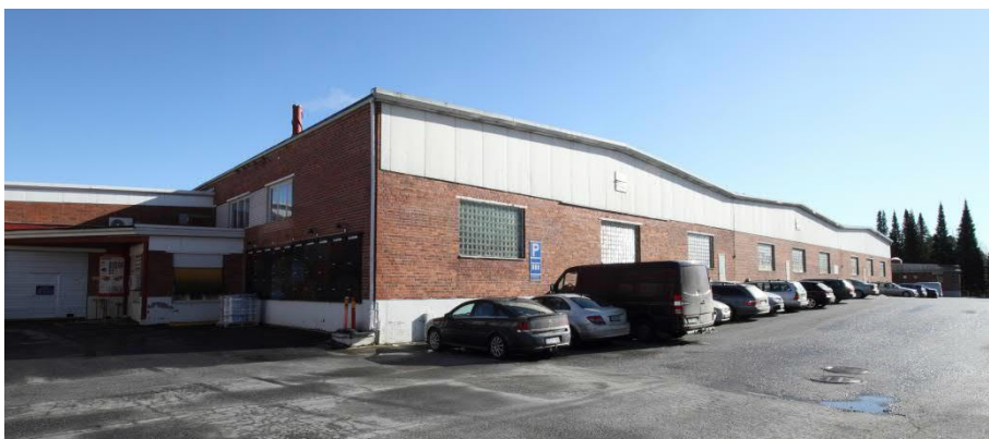
Kuva 31. Tehdaskompleksin eteläjulkisivua hallitsee 1960–1970-luvuilla rakennetut varastohallit. Pistoraide tehtaalle on kulkenut kuvan vasemmasta reunasta. Raiteen purkamisen jälkeen tehdasta on laajennettu raiteen paikalle. Kuvassa lähimpänä näkyvässä varastohallissa on alkujaan ollut kulmistaan pyöristetty lastauslaituri. Se on rakennettu ympeen ehkä jo 1980-luvulla.
