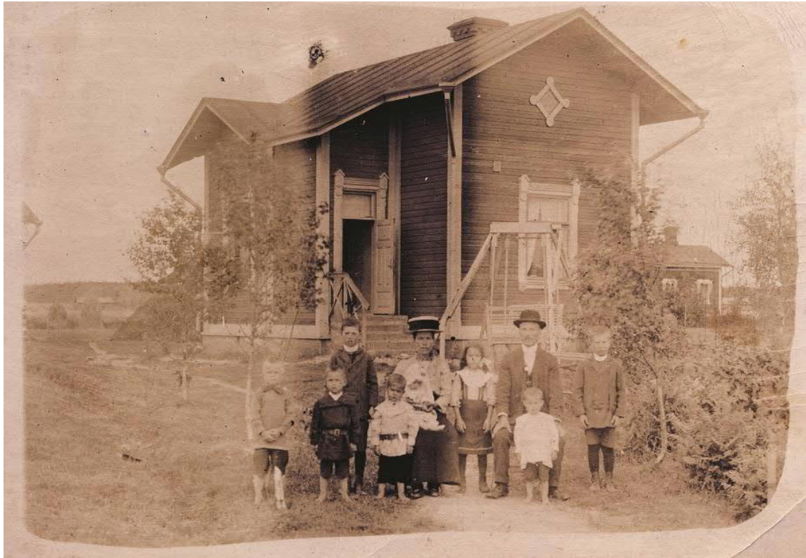
Kuva 5. Ajoittamaton mustavalkoinen valokuva Hollon vahtituvasta. Ihmisten vaateuksesta päätellen kuva on otettu 1900-alussa. Kuvassa rakennuksen vesikate on kattahuopaa kolmiorimoilla. Räystääiden alla ei ole tyyppikuvien mukaisia kattokonsoleita. Ilmeisesti ne lisätty rakennukseen vasta myöhemmin. Kuvaaja tuntematon. Kuvallähde: Lempäälän museo.
