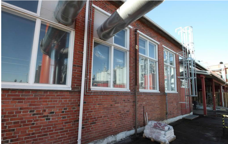
Kuva 32. 1950-luvulla rakennettu lämpökeskus näkyy nykyisin vain tehdaskompleksin sisäpihalle.
