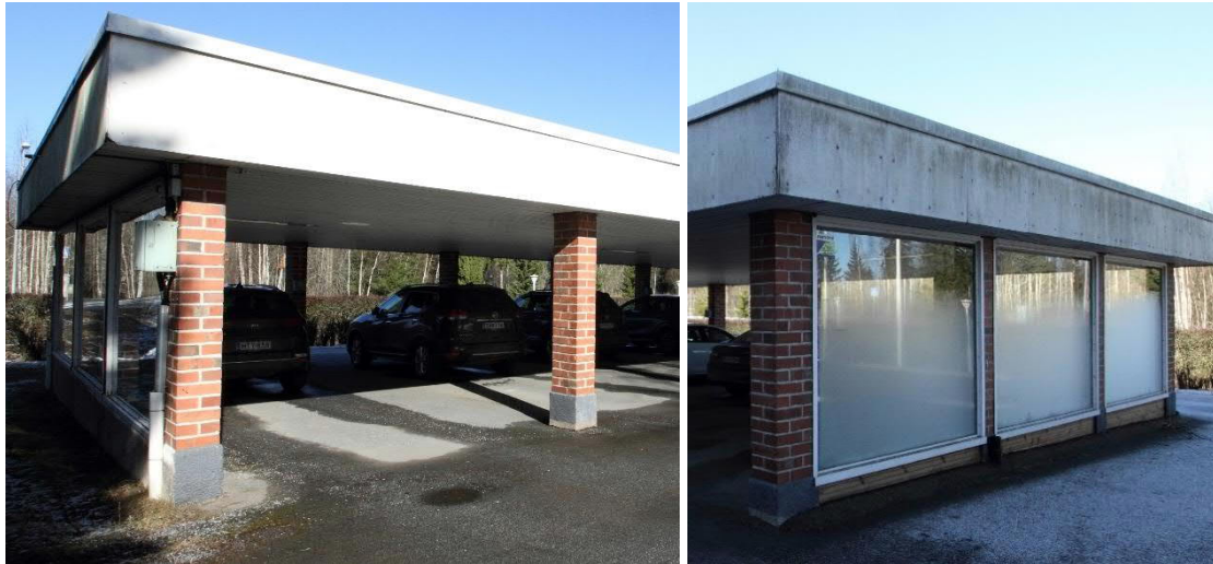
Kuva 48 (oikealla) Autokatos; Julkisivun ikkunat ovat joko alkuperäisiä tai ulkonäöltään täysin vastaavat.
