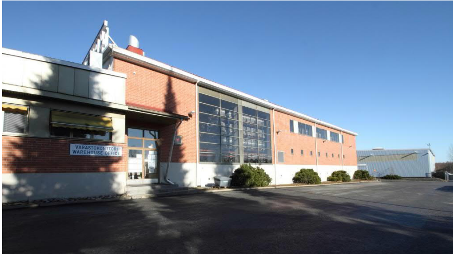
Kuva 38. Tehdaskompleksin itäpäättyyn rakennettiin vanhempien varastohallien jatkoksi 2000-luvulla vielä yksi uusi halli. Kuvassa näkyy hallin itäjulkisivu, jossa on koko julkisivun korkuiset isot ikkunat.
