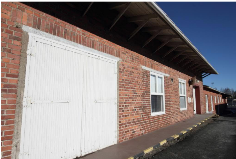
Kuva 36. Kemiallisen tehtaän itäjulkisivulla on säilynyt vanha leveä lastausovi. Ikkunat on uusittu.
