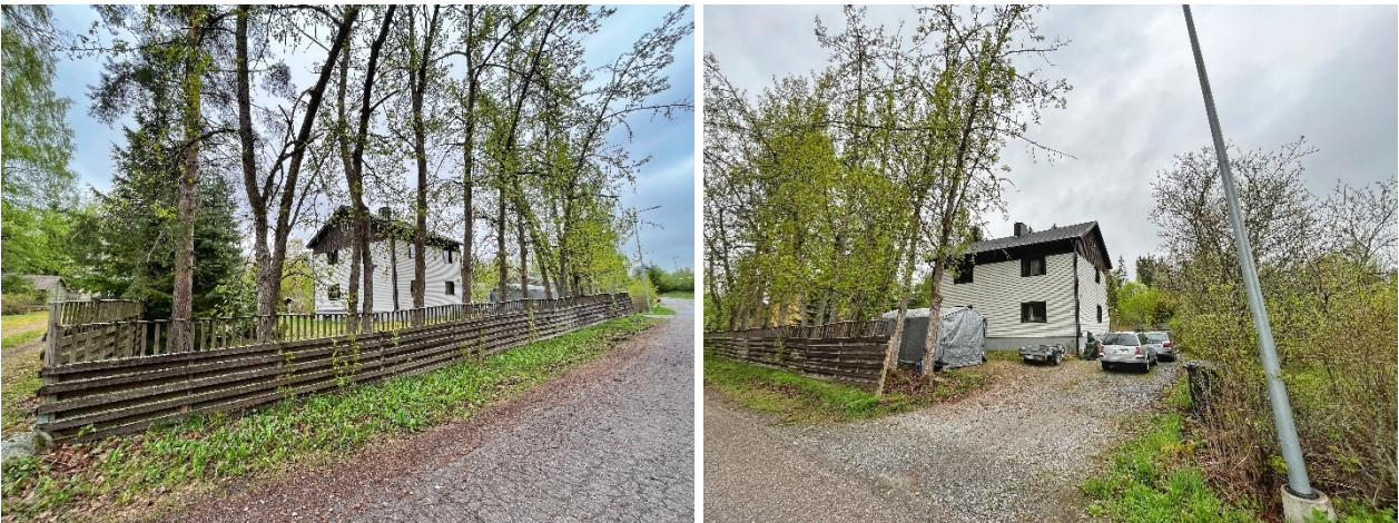
Kuvat. Näkymä Hakkarintieltä tontille ja tontilta purettava rakennus.
