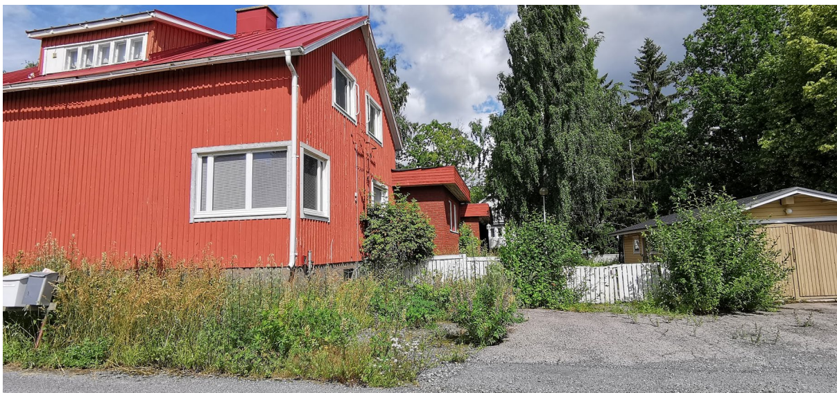
KUVA 9 Entinen päiväkotirakennus Tarikan- ja Rypyntien nurkassa (Nyström-Järvinen 2022)
