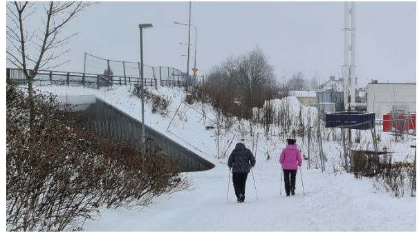
Kuvassa Valkeakoskentien alikulku 1/2021.
