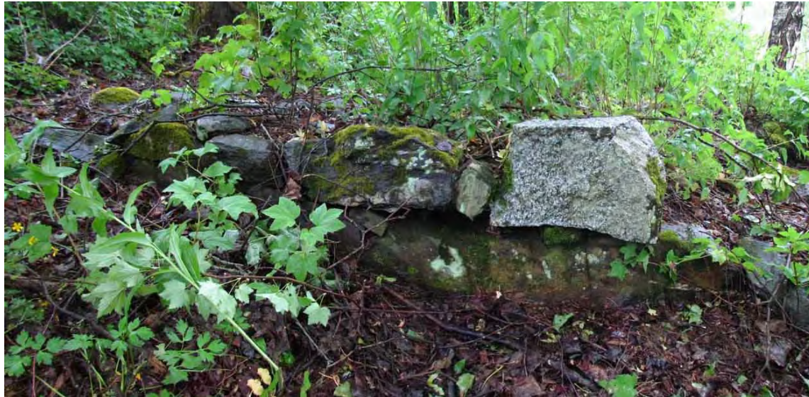
Kuva 18. Kylmämuurattua rakennuksenperustusta lähikuvassa. Kuvattu koillisesta. (Kuva: Lempäälä tarkkuusinventointi 2016: 17)
