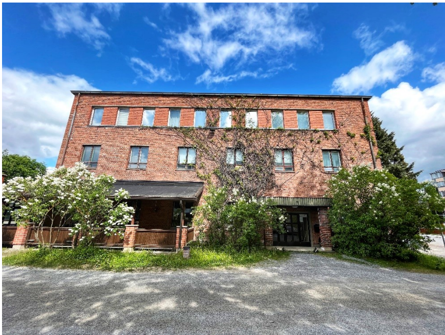
Tehtaan eteläjulkisivu (kuvattu 30.5.2023)
