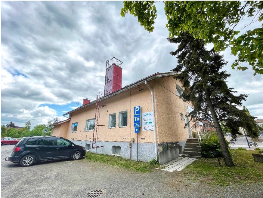
Rakennuksen pohjoisjulkisivu (kuvattu 30.5.2023)
