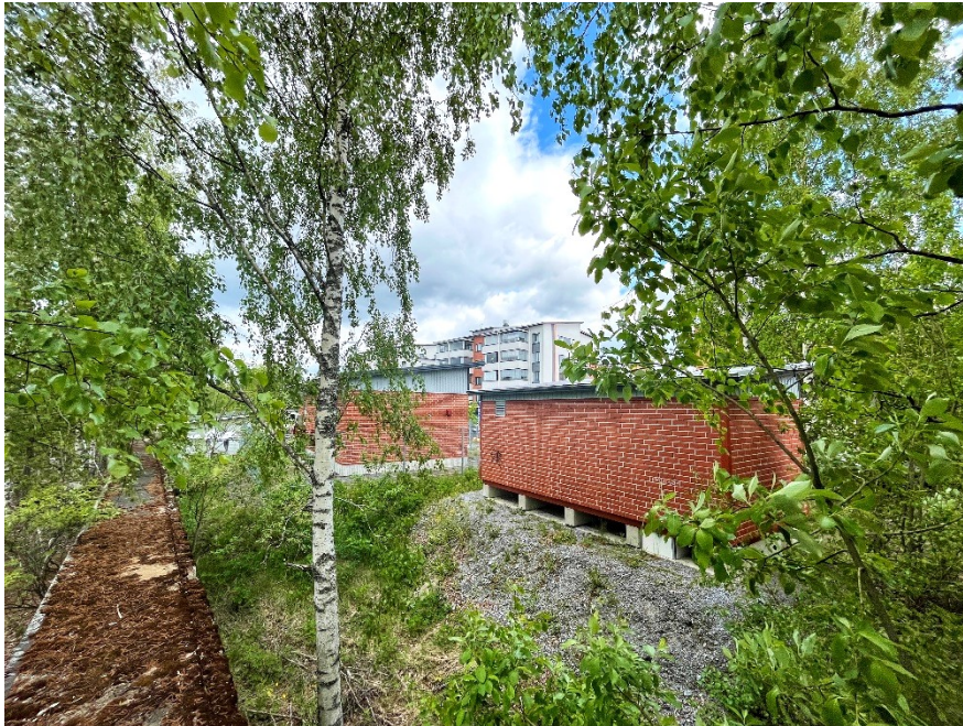
Näkymä rautatien suunnasta teknisille rakennuksille (kuvattu 30.5.2023)
