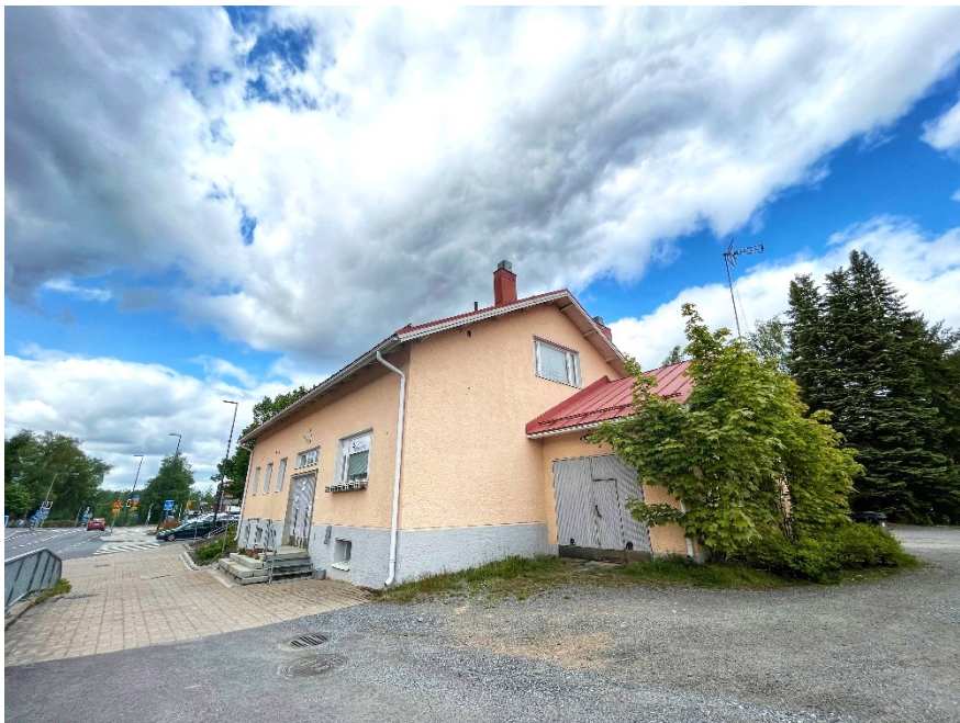
Rakennus etupihan suunnasta (kuvattu 30.5.2023)
