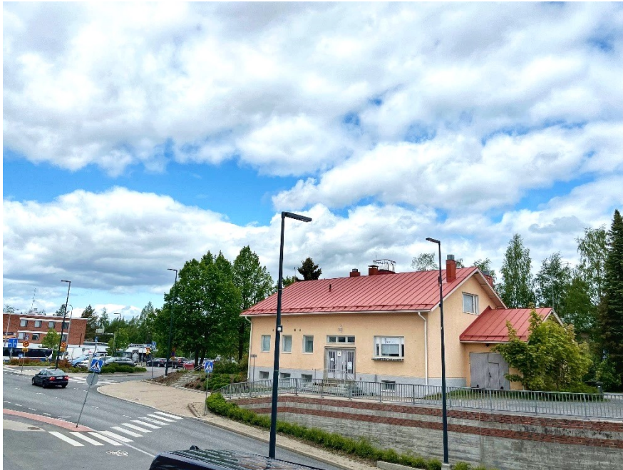
Rakennus eteläjulkisivu (kuvattu 30.5.2023)
