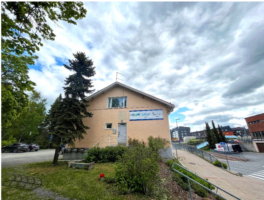
Rakennuksen länsijulkisivu (kuvattu 30.5.2023)
