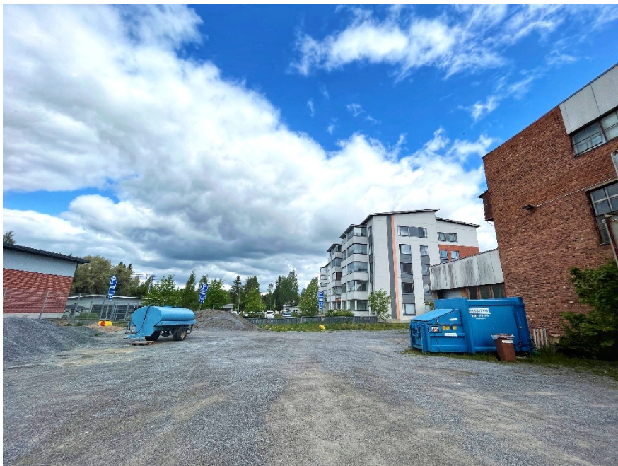
Näkymä tehtaalta sen pohjoispuolelta oleville kerrostaloille (kuvattu 30.5.2023)
