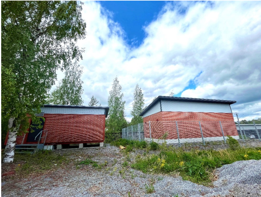
Tekniset rakennukset (kuvattu 30.5.2023)
