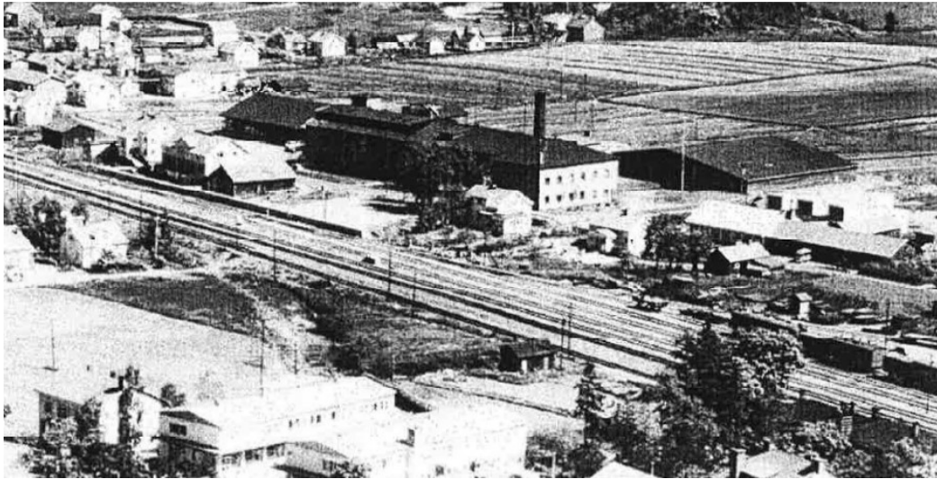
Piipon tehdasalue 1964, josta huomaa palomuurin eteläpuoleisen osan uudenvälisen harjakaton. Katto uusittiin vuoden 1951 tulipalon jälkeen.
