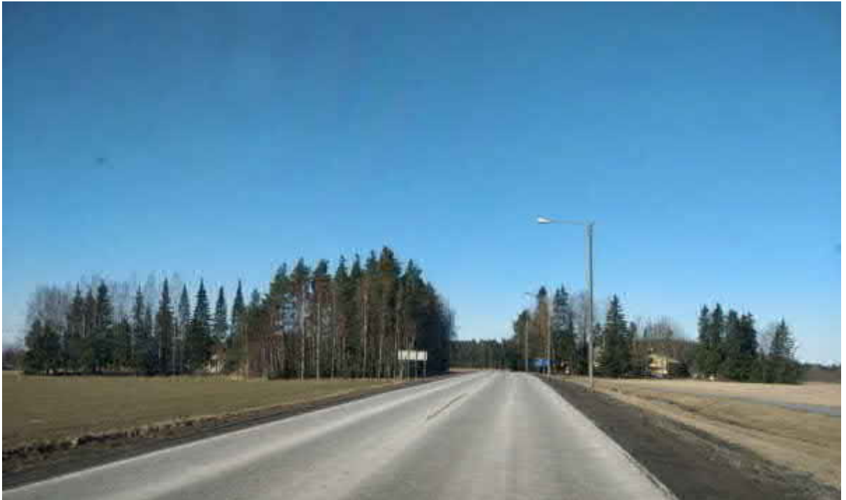
Kuva 4. Esitetty liittymäpaikka sijaitsee Vesilahdentiellä, oikeanpuoleisen metsäsaarekkeen vieressä.
