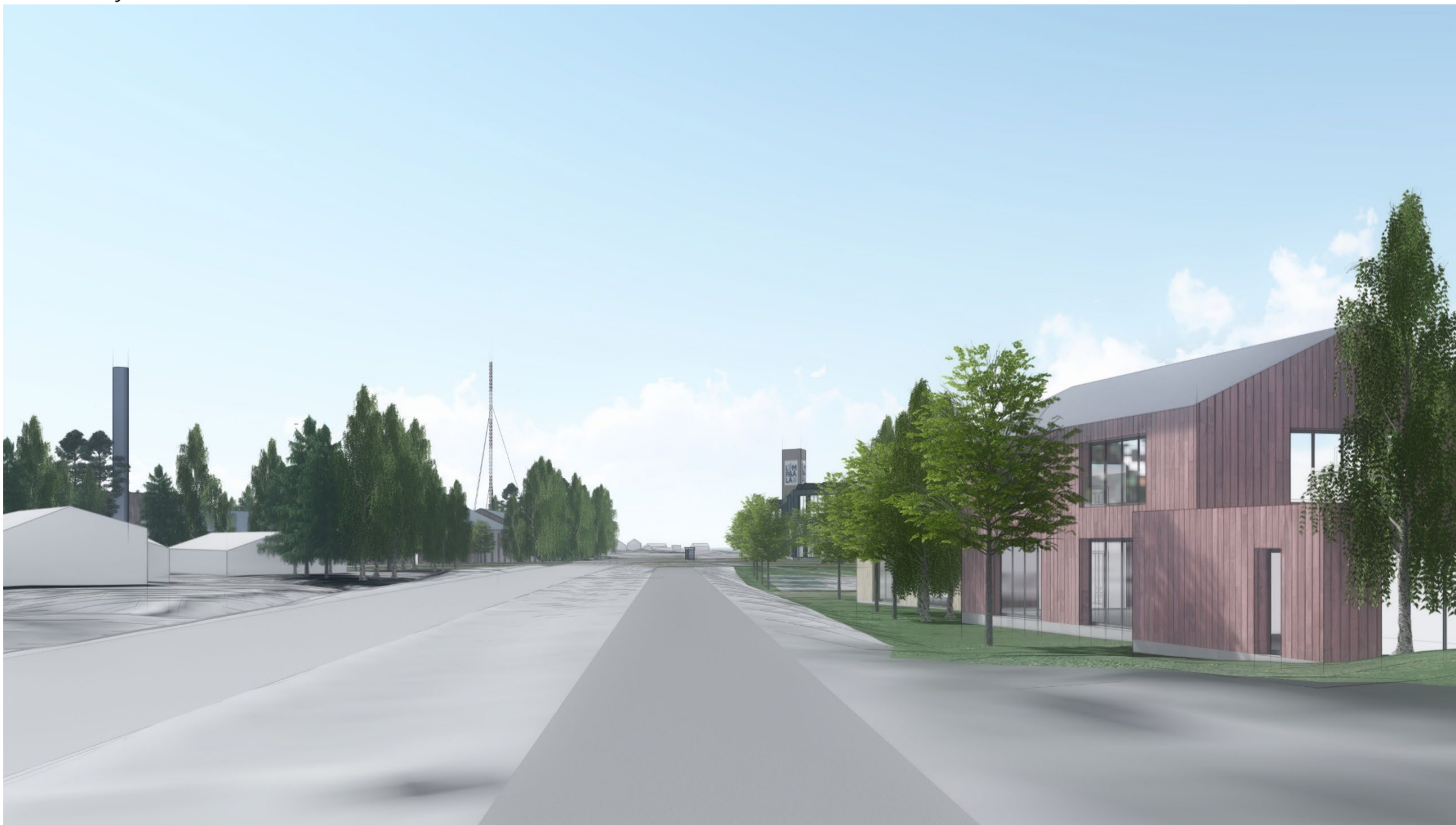
Kuva 4: Näkymä Viialantieltä etelään.
