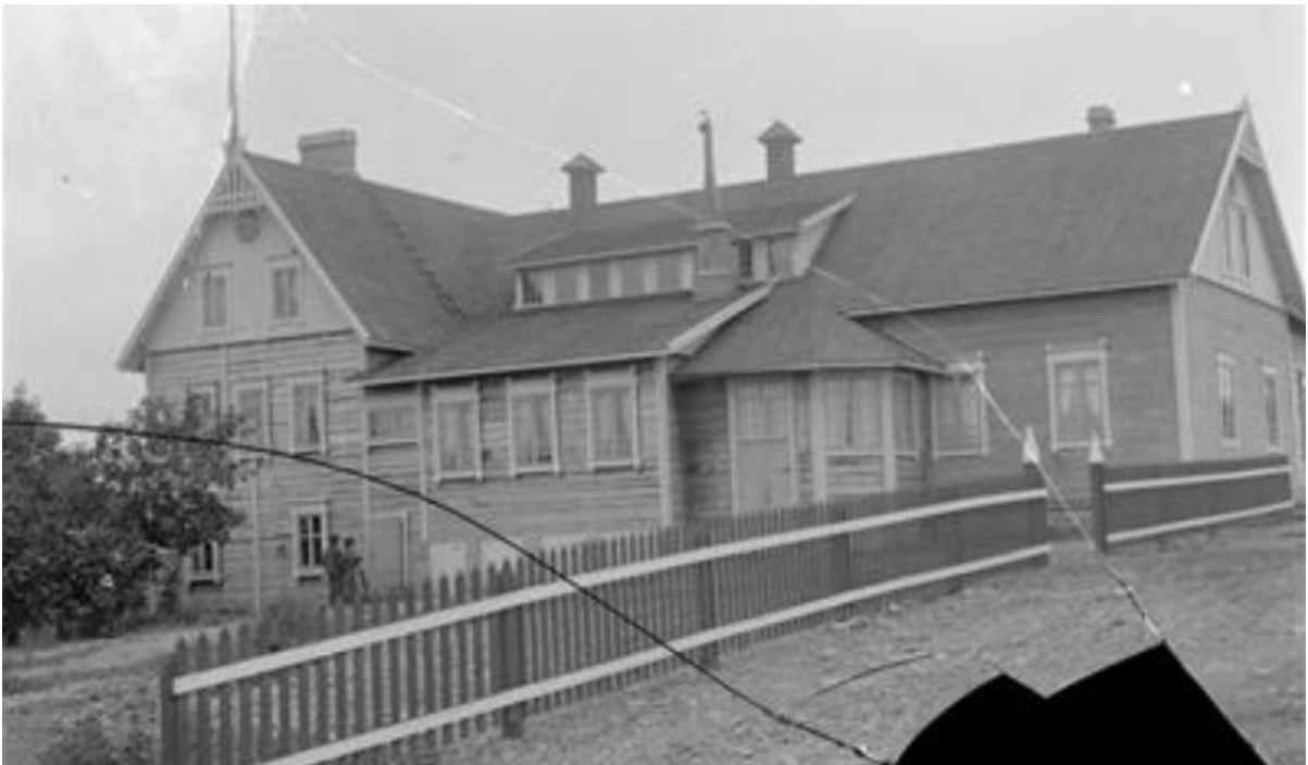
Kuvassa Nuijan talon itäjulkisivu sen pohjoispuoliselta tieltä tarkasteltuna. Tielinja on kehittynyt nykyiseksi Valkeakoskentieksi. Kuva: Lempäälä-Seura
