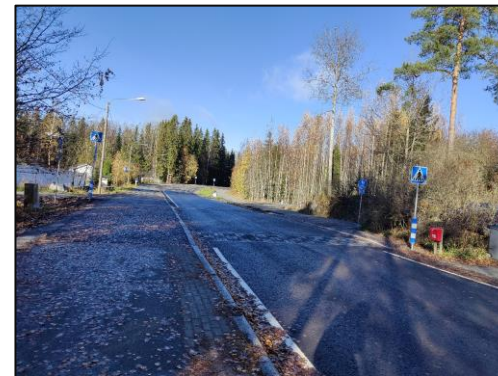
Asemakyläntielle on toteutettu uusia korotettuja suojaiteita. Sisennetyt reunaviivat saavat aikaan vaikutelman kapeammasta ajoradasta.
