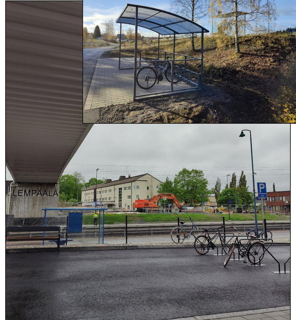
Runkolukittavia pyörätelineitä Kuljussa ja asemalaiturin vierellä. Sillan kansi ei suojaa pyöriä sateelta.
