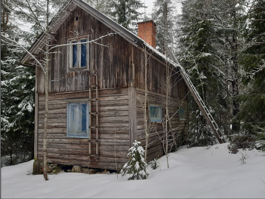
Kuva 11. Kiinteistöllä 418-439-3-4 sijaitseva asuinrakennus. Lähde: Lempäälän kunta 22.03.2023.
