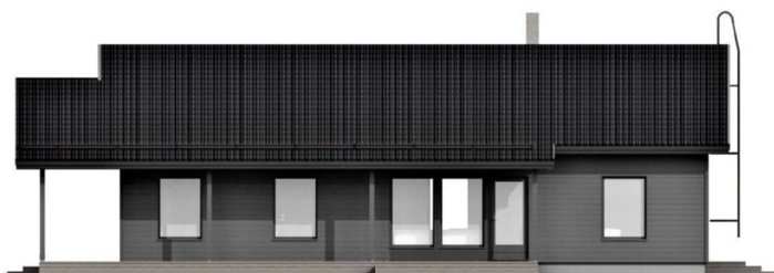
Talo julkisivu eteen
