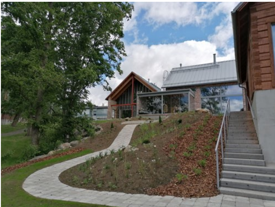
Kuva 5. Rakennukset rannan puolelta kuvattuina
