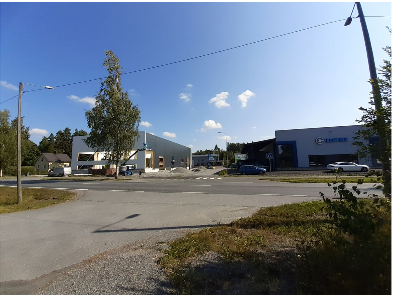
Kuva. Kaava-alueen edustalla on vuonna 2021 valmistunut toimitarakennus sekä puretun Sääksjärvitalon tilalle rakenteilla oleva toimitilarakennus, jotka ovat kummatkin sisätiloiltaan korkeita ja rinnastettavissa 2-kerroksiseen rakentamiseen (rakenteilla olevan toimitilarakennuksen räystäskorkeus on noin 10 metriä maanpinnasta).
