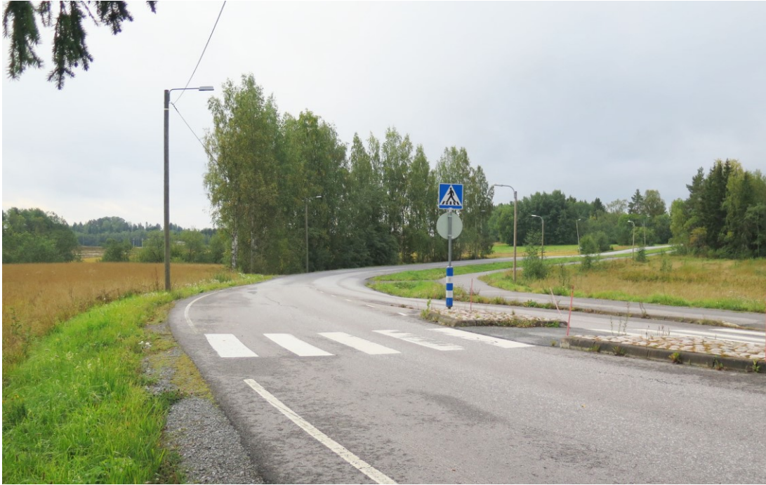
Kuva 7. Vanattarantietä Vallinmäentien liittymästä etelään päin
