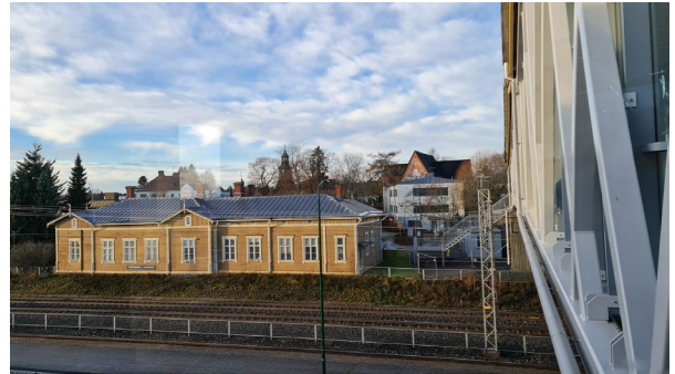
Kuvassa vanha asemarakennus Lempäälä-talolta, kirjaston pääsisäänkäynnin suunnasta 11/2020.
