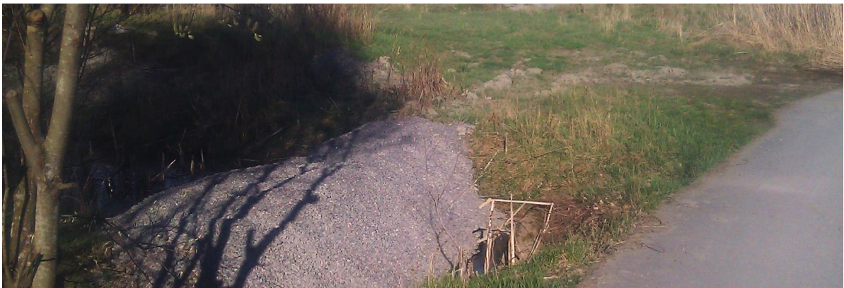
Kuva 5. Avo-ojan eteen rakennettu väliaikainen suodattava murskepato. Turku, Haarlanlahti.
