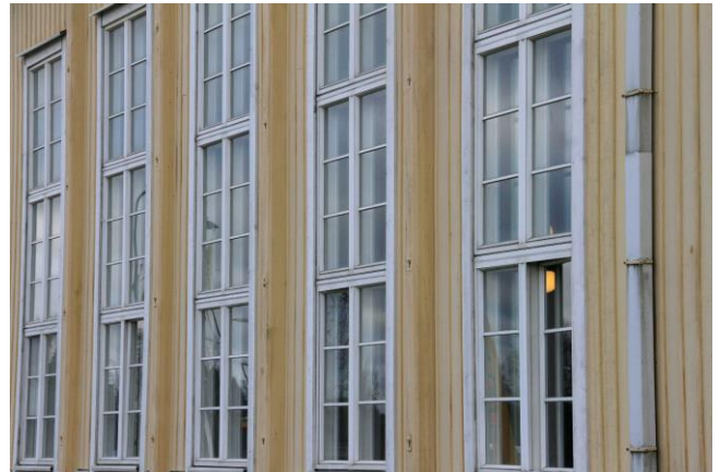
Juhlasalin korkea ikkunarivistö. Hirsirakennetta ikkunoiden väleissä tukee följarit. Juhlasalin ikkunat, samoin kuin muutkin ikkunat, on uusittu 1990-luvulla vanhan mallin mukaan. Kuva nro 6798
