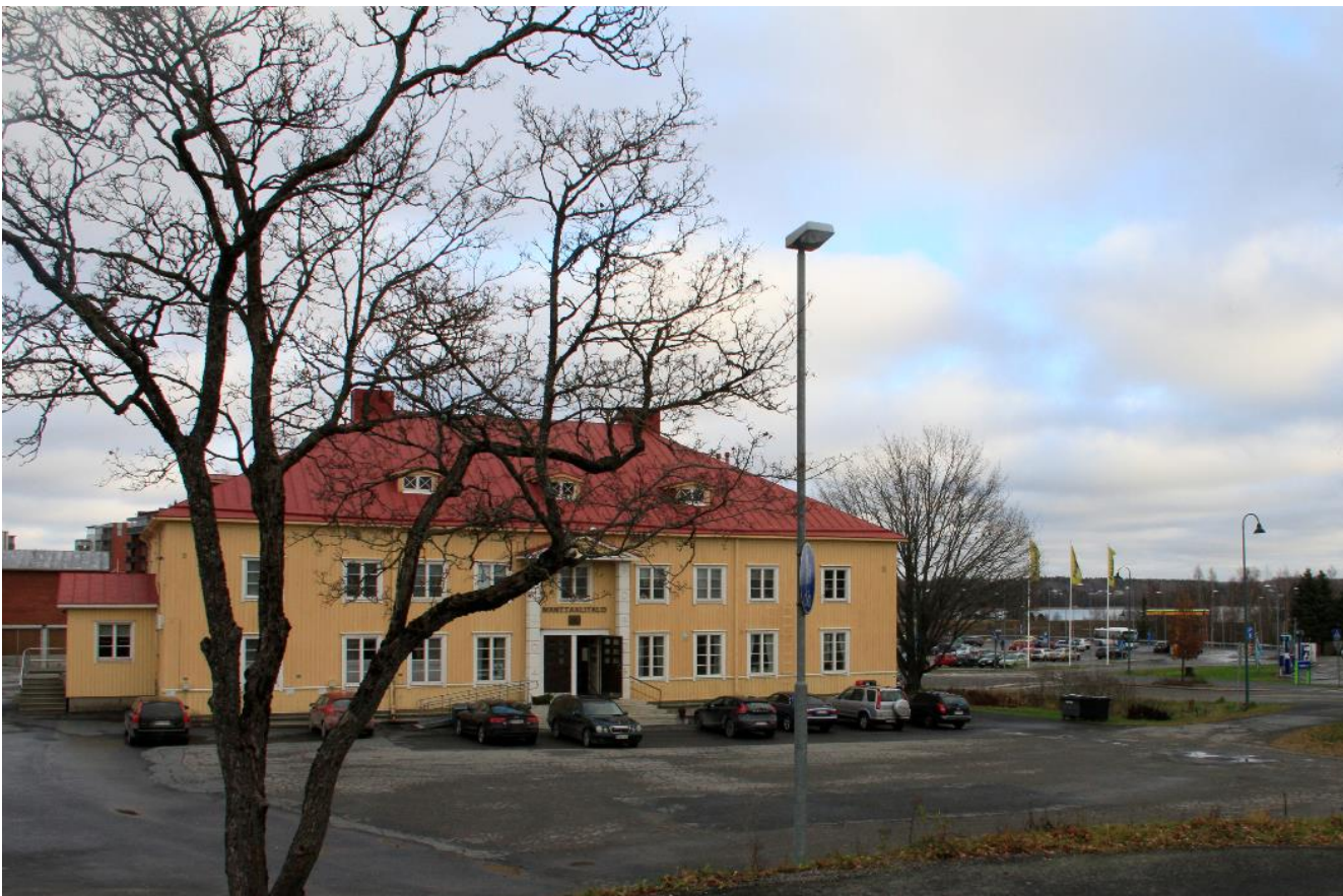
Manttaalitalon Valkeakoskientien puoleinen etäljulkisivu pääsisäänkäyntineen. Kuvan oikeassa laidassa näkyy Ahtialanjärveä, jonne Valkeakoskientieltä avautuu näkymä Manttaalitalon ohitse. Kuva nro 6805
