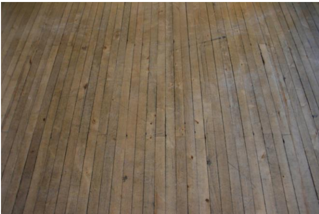
Juhlasalissa on alkuperäinen puulattia. Kuva nro 6830
