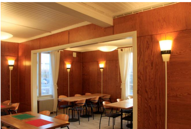
Kahvion seinät on paneloitu puuviilulla. Panelointi on uusittu vanhan mallin mukaan äskettäin. Samalla lattia on päällystetty vinyylimatolla. Kuva nro 6825
