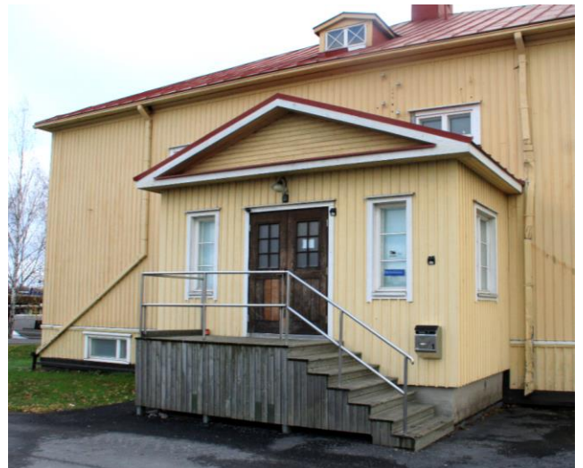
Länsijulkisivun kuisti on rakennettu suurelta osin uudestaan 1990-luvun korjausten yhteydessä. Kuistin vasemmalla puolen näkyy 1960-luvulla kellariin tehtyjen wc-tilojen ikkuna. Kuva nro 6794
