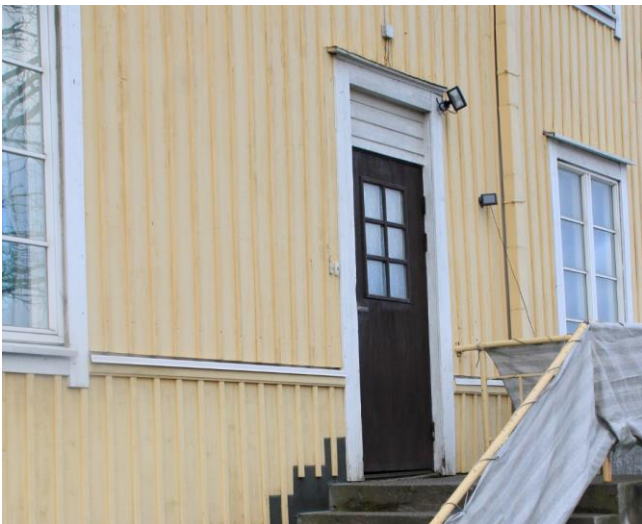
Keittiöpäädyn sisäänkäynnin alkuperäinen ovi on ollut nykyistä ovea korkeampi tai sen yllä on ollut ikkuna. Kuva nro 6789
