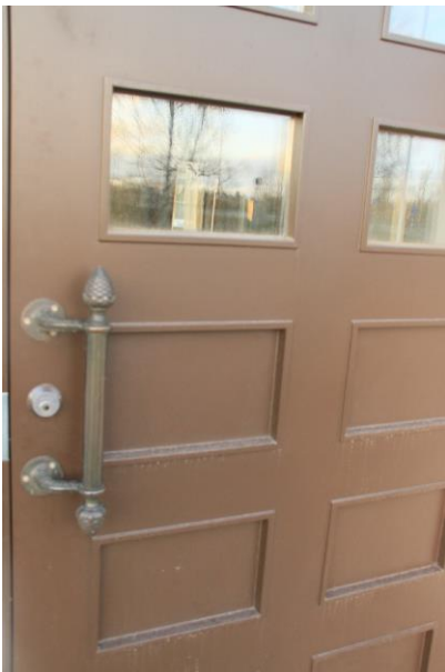
Manttaalitalon pääulko-ovet on uusittu vanhan mallin mukaisiksi. Uusiin oviin on siirretty vanhat koristeelliset ovenkahvat. Kuva nro 6821
