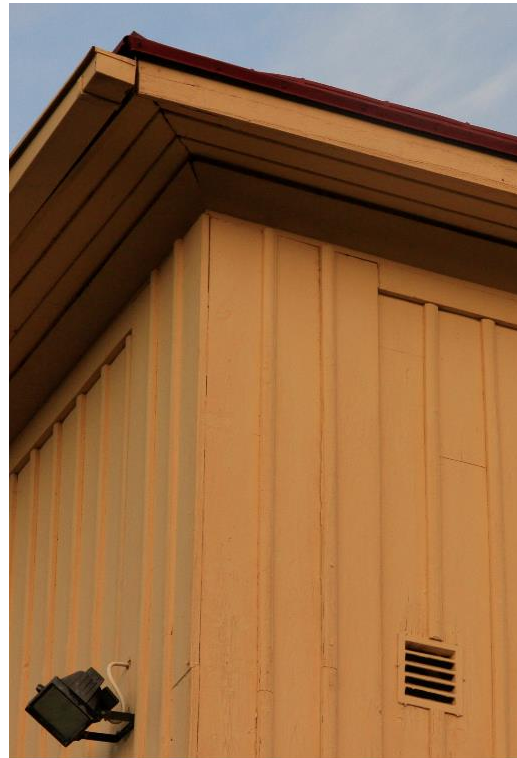
Nykyisin Manttaalitalon nurkkalistat eivät erotu selvästi muusta julkisivupinnasta, koska ne on listoitettu samaan tapaan kuin julkisivut muutenkin ja maalattu samalla värillä. Rakennus on alkujaan ollut hirsipintainen, jolloin nurkkalistat ovat erottuneet selvemmin muusta julkisivusta. Kuva nro 6819
