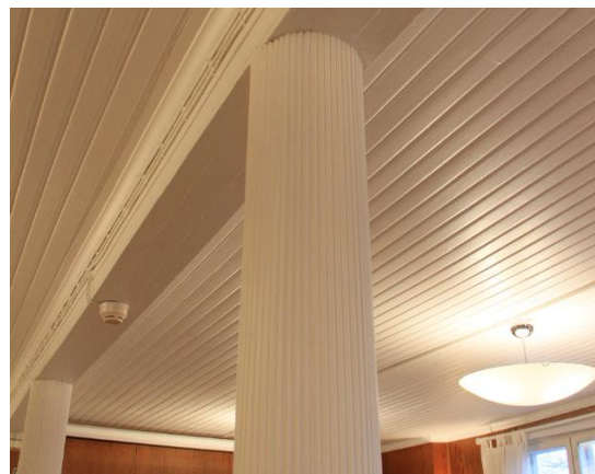
Kahviossa välipohjarakenteita kannattaa kaksi pyöreää pylvästä, jotka on paneloitu sormipaneelilla. Kuva nro 6826
