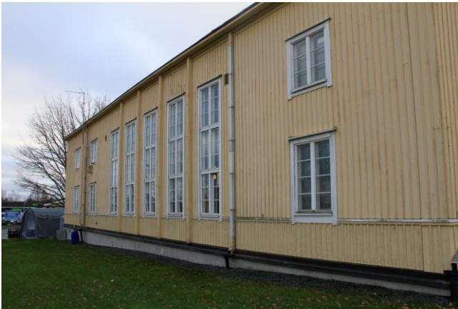
Manttaalitalon Manttaalitien puoleinen pohjoisjulkisivu. Keskellä rakennusta on juhlasalin korkeat ikkunat. Kuva nro 6797
