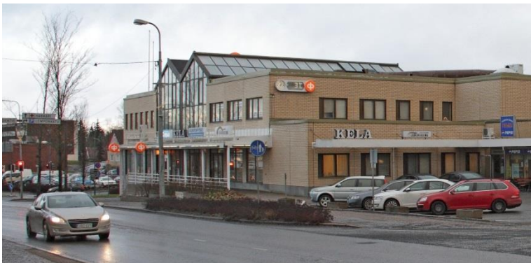
Kuva 25. OP-Centerin julkisivu Tampereentielle.
