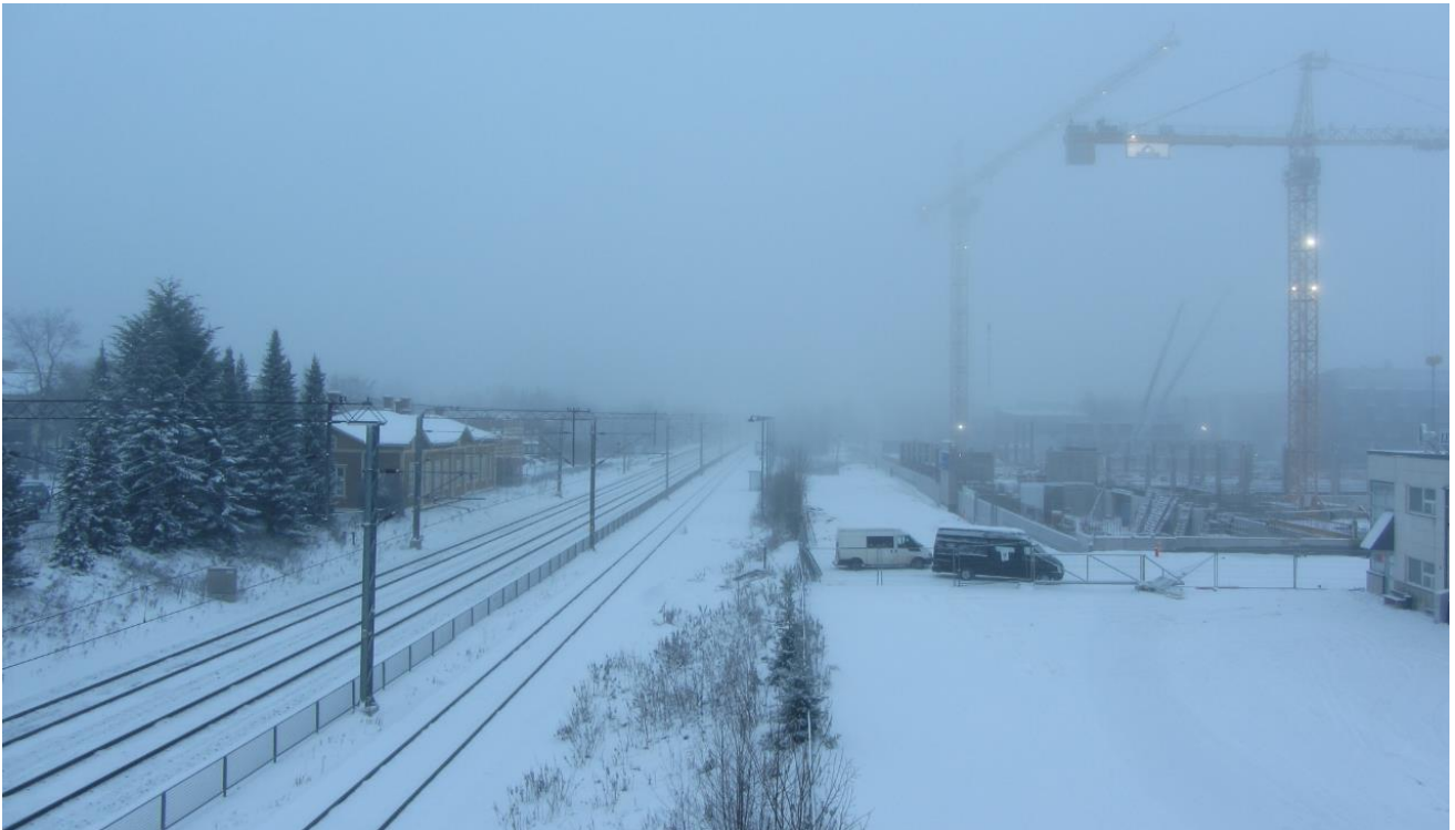
Kuva 32. Kuvassa vuodelta 2019 näkyy, että puustoa on kaadettu aseman pohjoispuolelta uutta Telkän Taipaleen ylikulkua varten. Kuvassa näkyy valussa oleva uusi siltapiilarit aseman pohjoispuolella sekä radan itäpuolen rakennustyömaat. Kuva: Maija Villanen.
