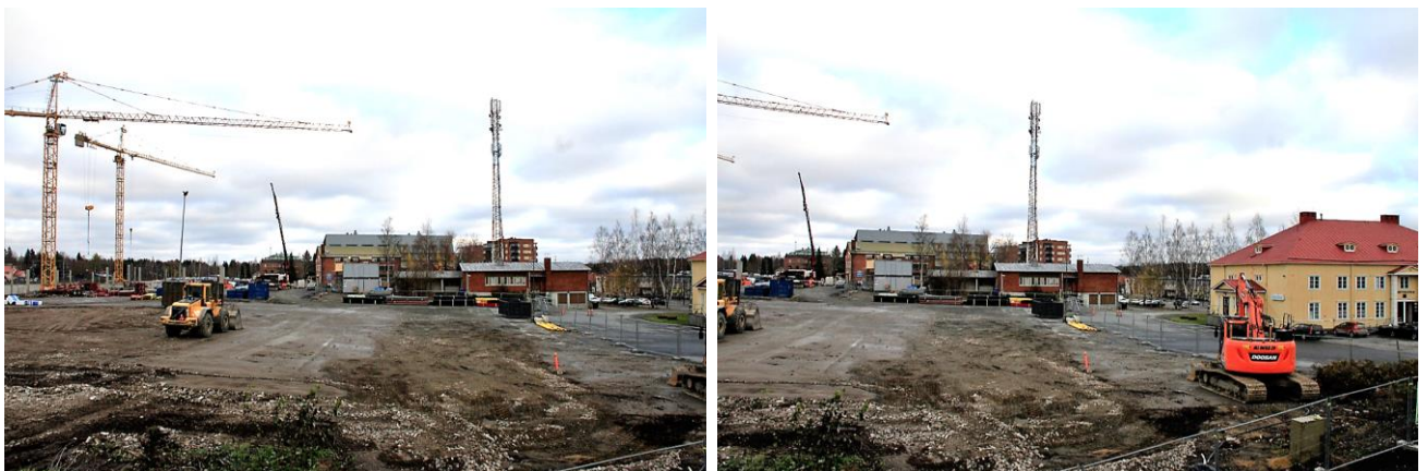
Kuva 33. Rakennustyömaata Manttaalitalon ja radan välissä vuonna 2019. Tenkasen myllyn ja entisen puhelinkeskuksen takana näkyy vuonna 2018 valmistunut asuinrakennus. Rakennuksen voimakas kattomuoto ja väritys ovat tuoreen asemakaavan mukaisia. Kaavalla muodostetaan uutta kuntakeskusta ja kaupunkimaista ulkoasua aseman ympäristöön.
