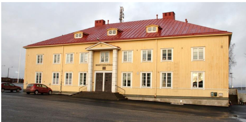
Kuva 9. Manttaalitalon eteläjulkisivu Valkeakoskentien puolella.
